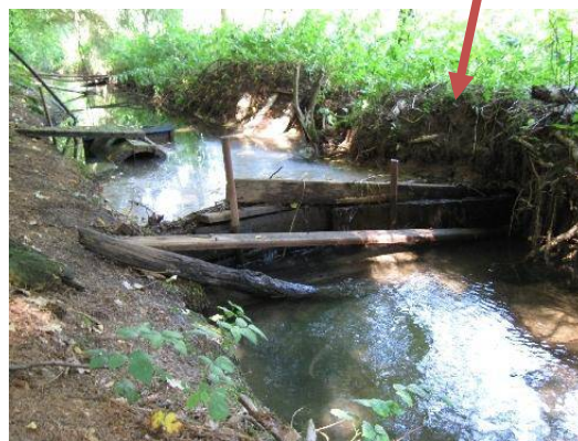
Obr.30 - hráz Nový Berštejn (foto Váša 2010)
