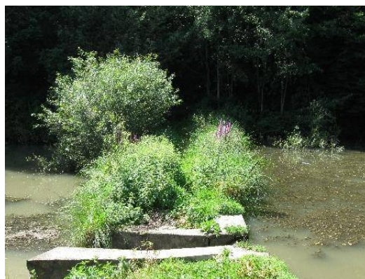
Obr.25 - hráz a výpustné zařízení Mlýnek II. (foto Váša 2010)
