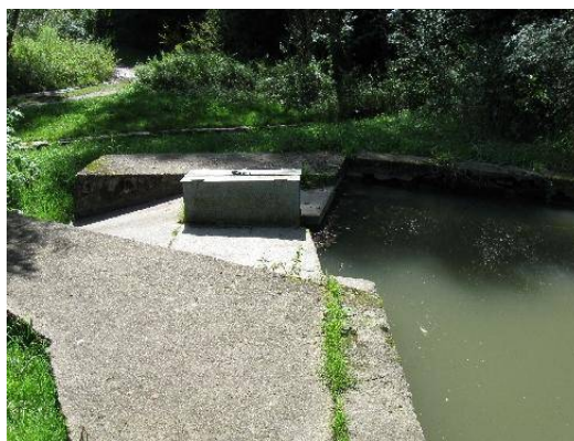
Obr.26 - sdružený objekt nádrže Mlýnek I. (foto Váša 2010)
