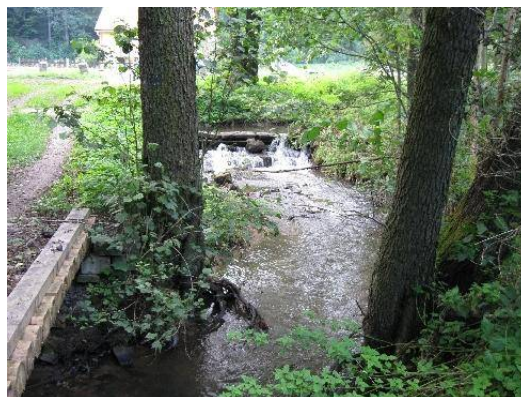
Obr.41 - jez nad Bukoveckým mlýnem (foto Váša 2010)
