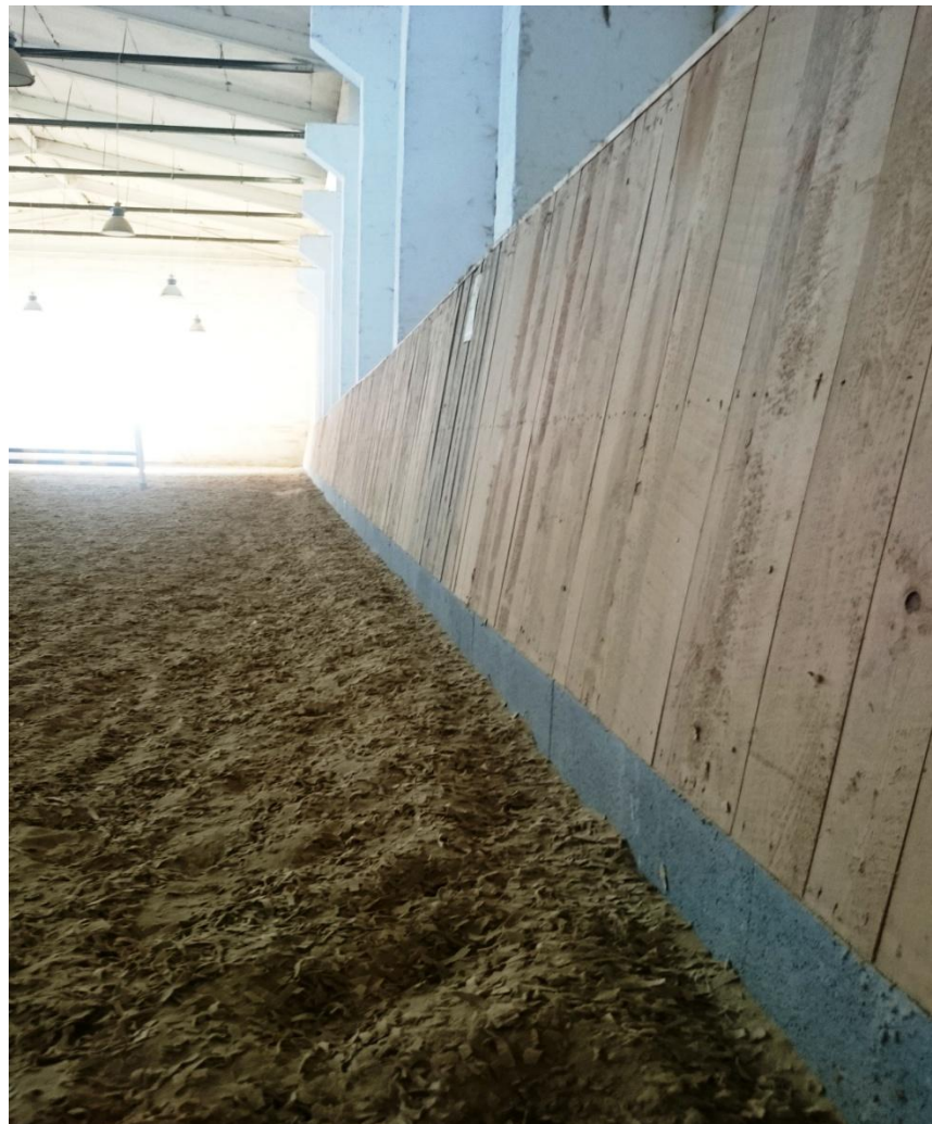
Obr. 10 Zkosení obvodových stěn v jízdárně a namíchaný písek s geotextilií
