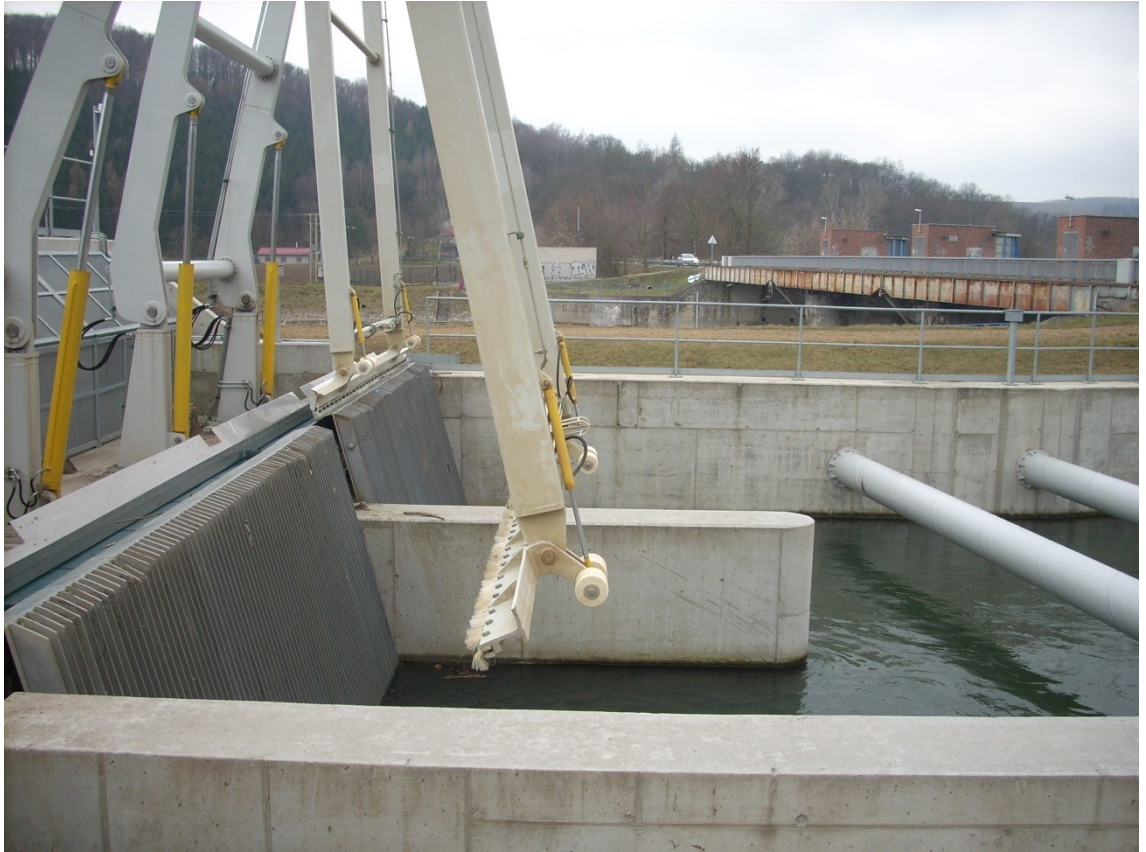
Obrázek 11 – Hydraulicky ovládané čistící stroje jemných česlí (Veronika Slováková, 14. 3. 2015)
