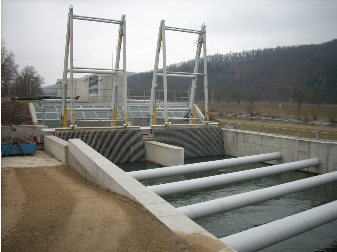
Obrázek 9 – Malá vodní elektrárna Bělov, jemné česle, po pravé straně tok řeky Moravy, po levé straně kontejner pro shrabky (Veronika Slováková, 15. 3. 2015)
