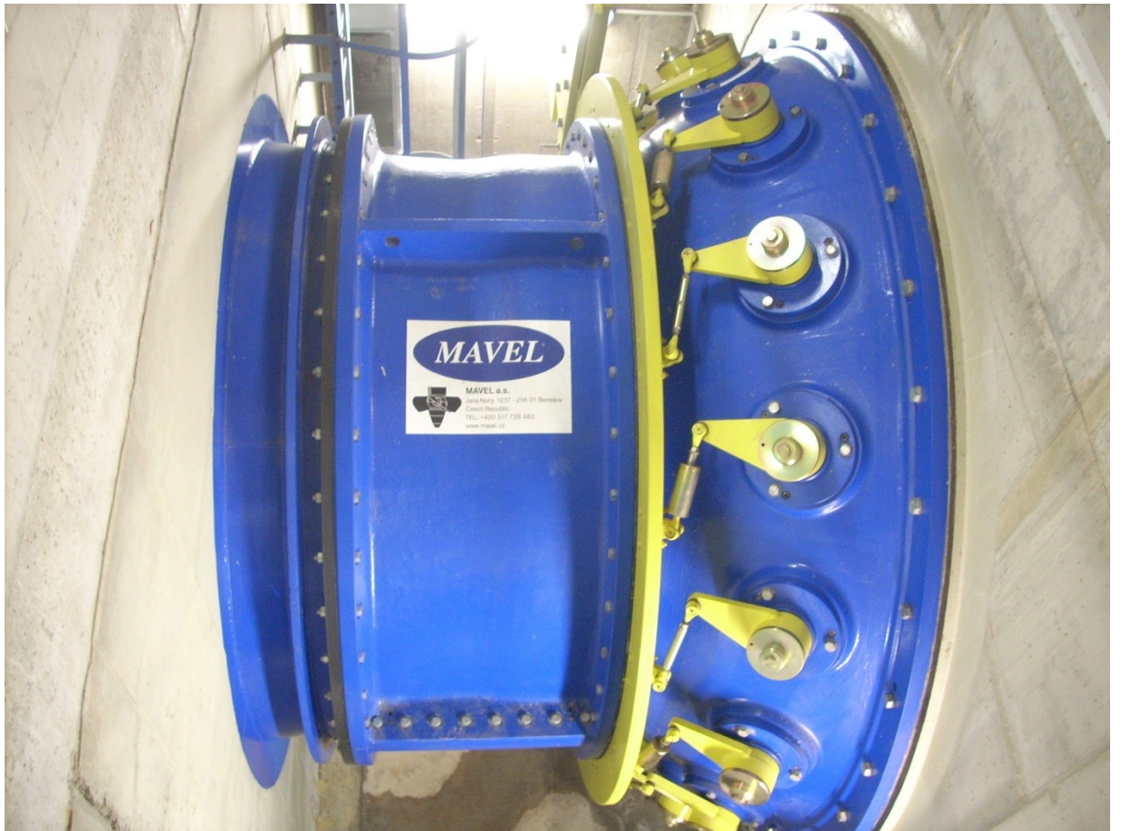
Obrázek 12 – Kaplanova turbína dodaná výrobcem MAVEL a. s. v MVE Bělov (Foto: Veronika Slováková, 14. 3. 2015)
