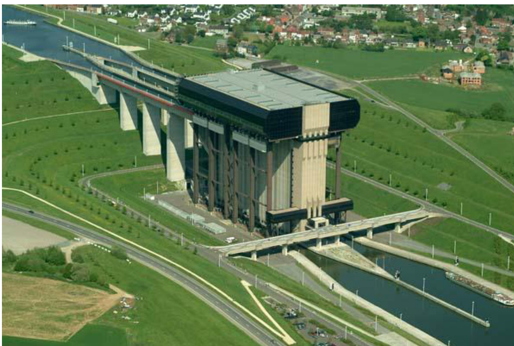
Obr. č. 29.: Lodní zdvihadlo Strépy v Belgii s mostovou konstrukcí.
