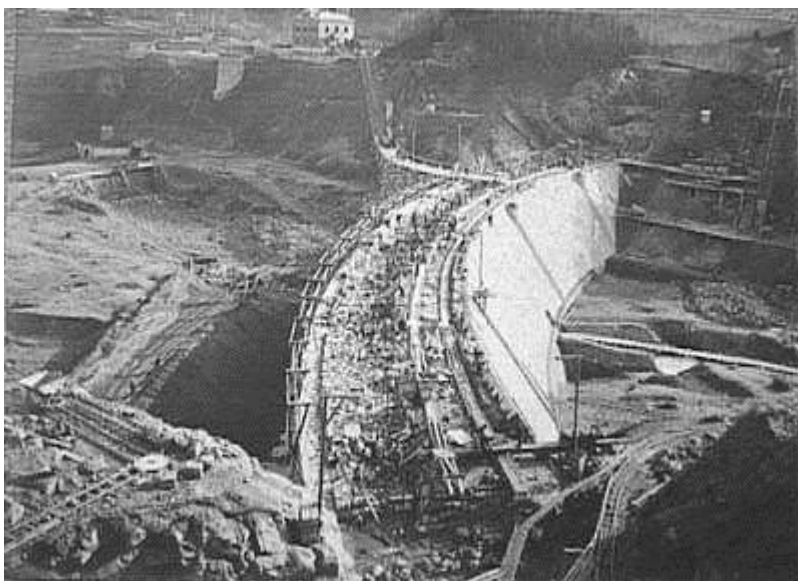
Obr. č. 50.: Historická fotografie průběhu výstavby přehrady Bystřička.
