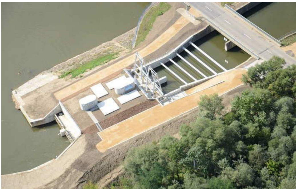
Obr. č. 58.: Nově dokončená MVE Bělov na Bat'ově kanálu.
