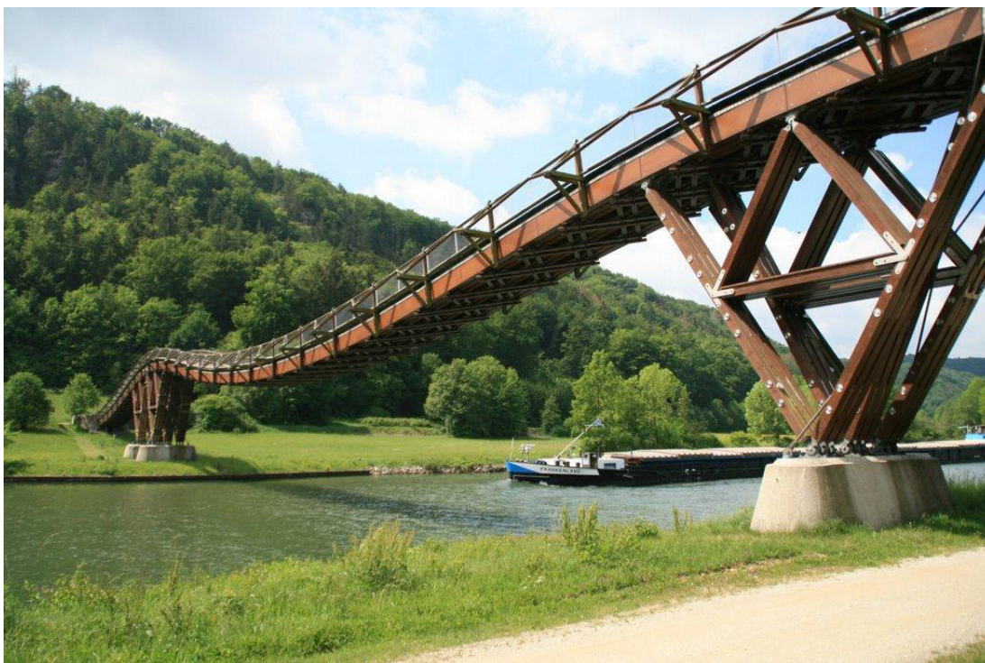
Obr. č. 53.: Průplav Mohan-Dunaj u obce Essing. Unikátní vysutá lávka.
