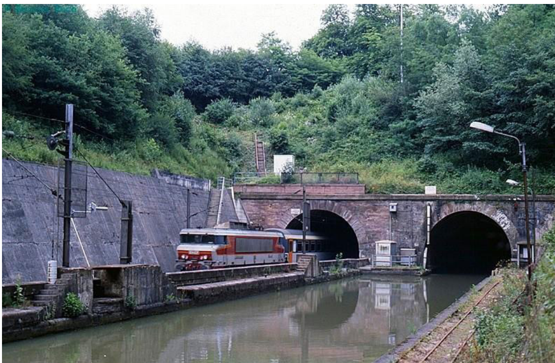
Obr. č. 34.: Průplavně-železniční tunel Arzviller na průplavu Marna-Rýn.
