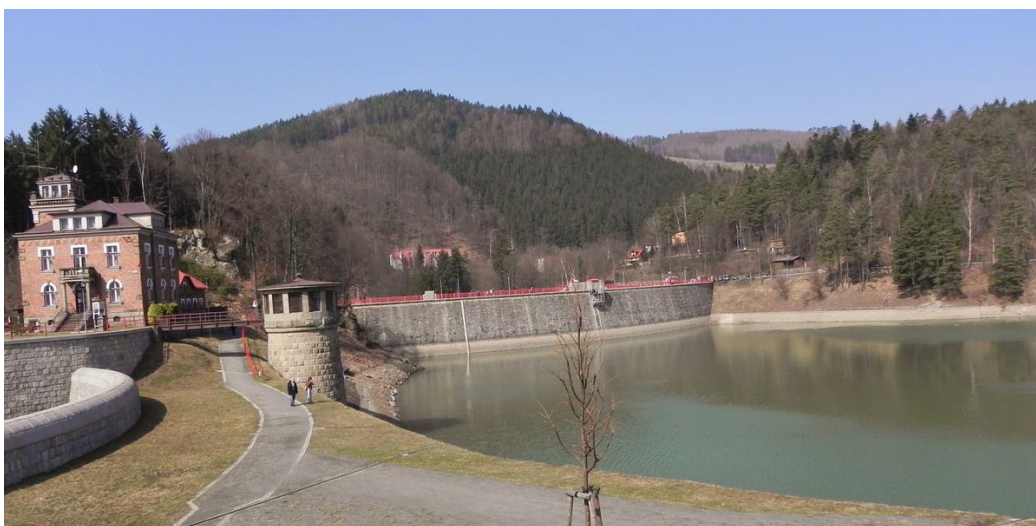
Obr. č. 51.: Přehradní těleso Bystřička.
