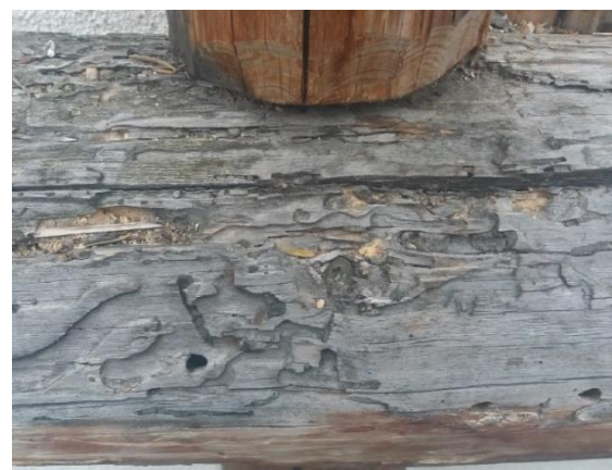
Obrázek 22: Požerky dřevokazného hmyzu
