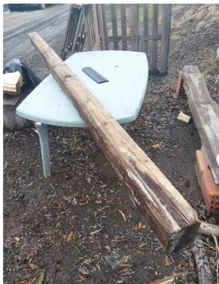
Obrázek 25: Vybraná pozednice krovu
