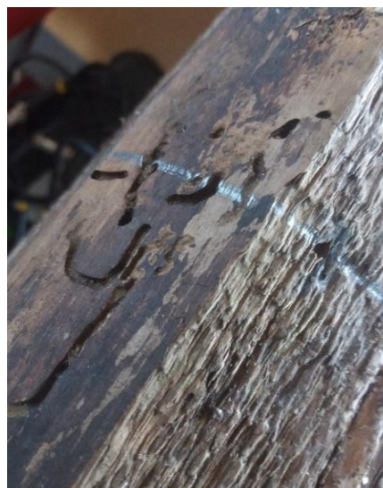
Obrázek 28: Napadení červotočem proužkováným
