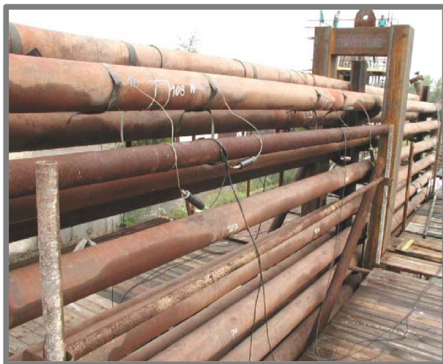
Obr. 2.2 Aplikace akustické emise na transportním potrubí [4]
