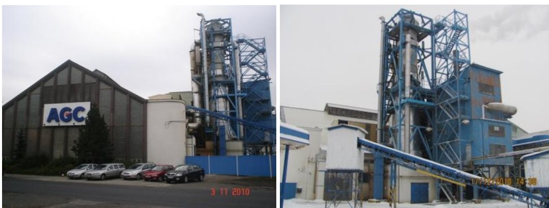
Foto č. 8 a 9: Pohled na spalínový rekuperátor výrobní linky D1, (č. 8, vlastní zpracování 2010, č. 9, podnik Barevka 2011)
