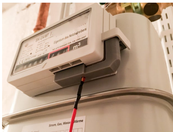
Obr. 2.13: Nástavce pro upevnění jazýčkového kontaktu k plynoměru Elster BK-G4M [15].
