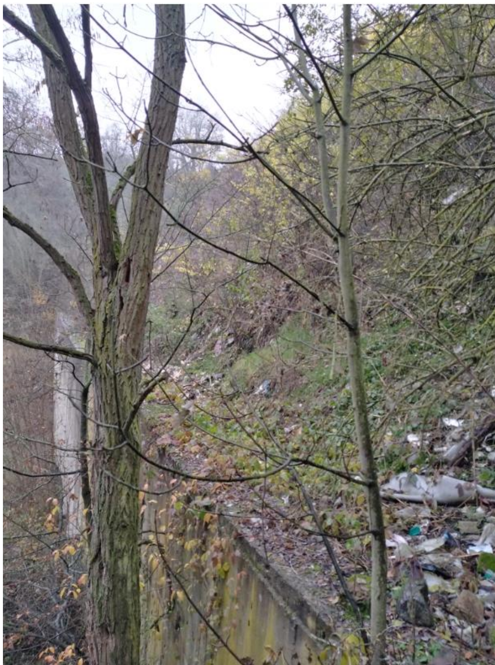
Příloha 5: Fotodokumentace lokality – opěrná zeď čela skládky směr Židovská rokle
