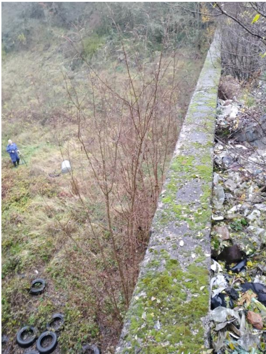
Příloha 4: Fotodokumentace lokality – pohled z opěrné zdi
