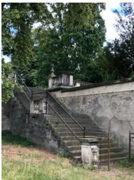
Obrázek 24- Přímé dvouramenné schodiště v západním parteru (foto: autor)
