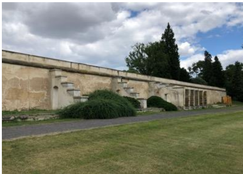
Obrázek 18 - Podpěrná zeď ve východním parteru (foto: autor)
