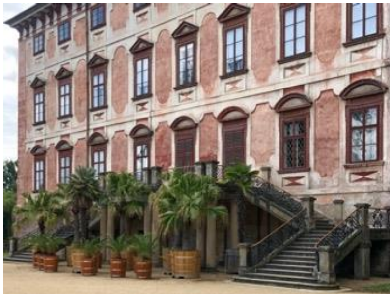
Obrázek 14 - Zahradní pískovcové schodiště ve východním křídle zámku (foto: autor)
