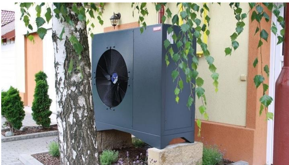
Obr. 3.3: Príklad umiestnenia tepelného čerpadla vzduch - voda [6].
