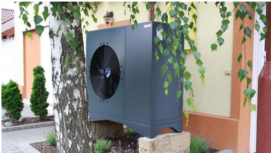
Obr. 3.3: Příklad umístění tepelného čerpadla vzduch - voda [6].
