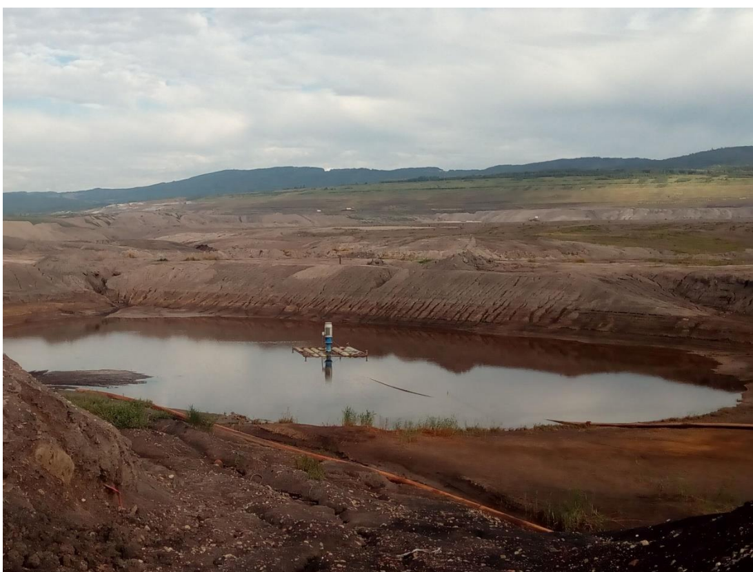
Obrázek 13: Čerpání důlních vod mobilní čerpací stanicí v dobývacím prostoru DNT.
