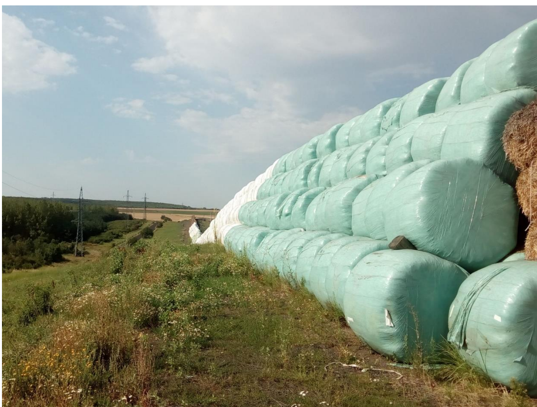
Obrázek 19: Ochranný mobilní val (ze slámy) u obce Březno u Chomutova.
