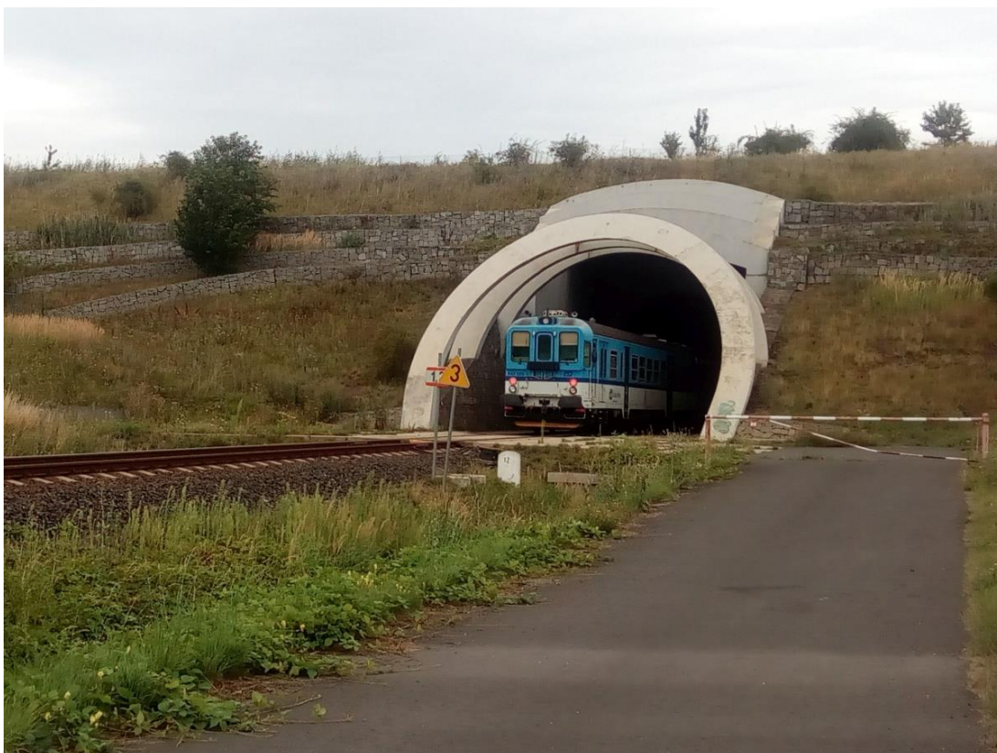
Obrázek 20: Březenský tunel na železniční trati Praha – Chomutov.
