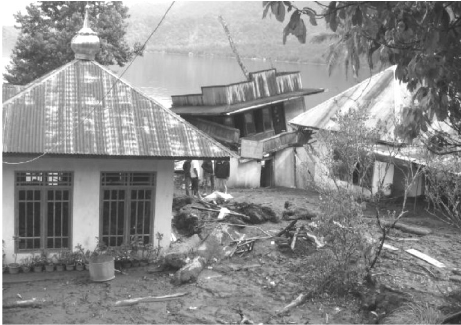
Obrázek 14: Poškozené domy následkem zemětřesení v roce 2009
