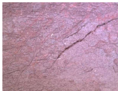
Obr. 33) Detail na oblast Y [foto autor]
