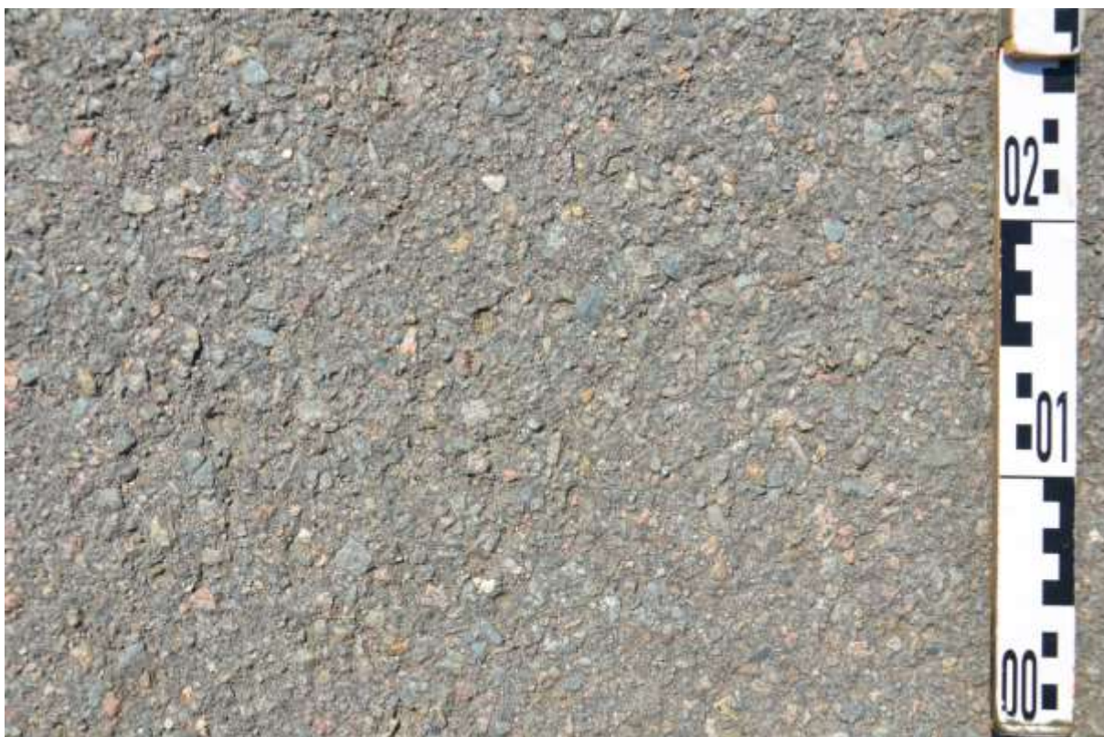
Obr. 17 Detail povrchu vozovky
