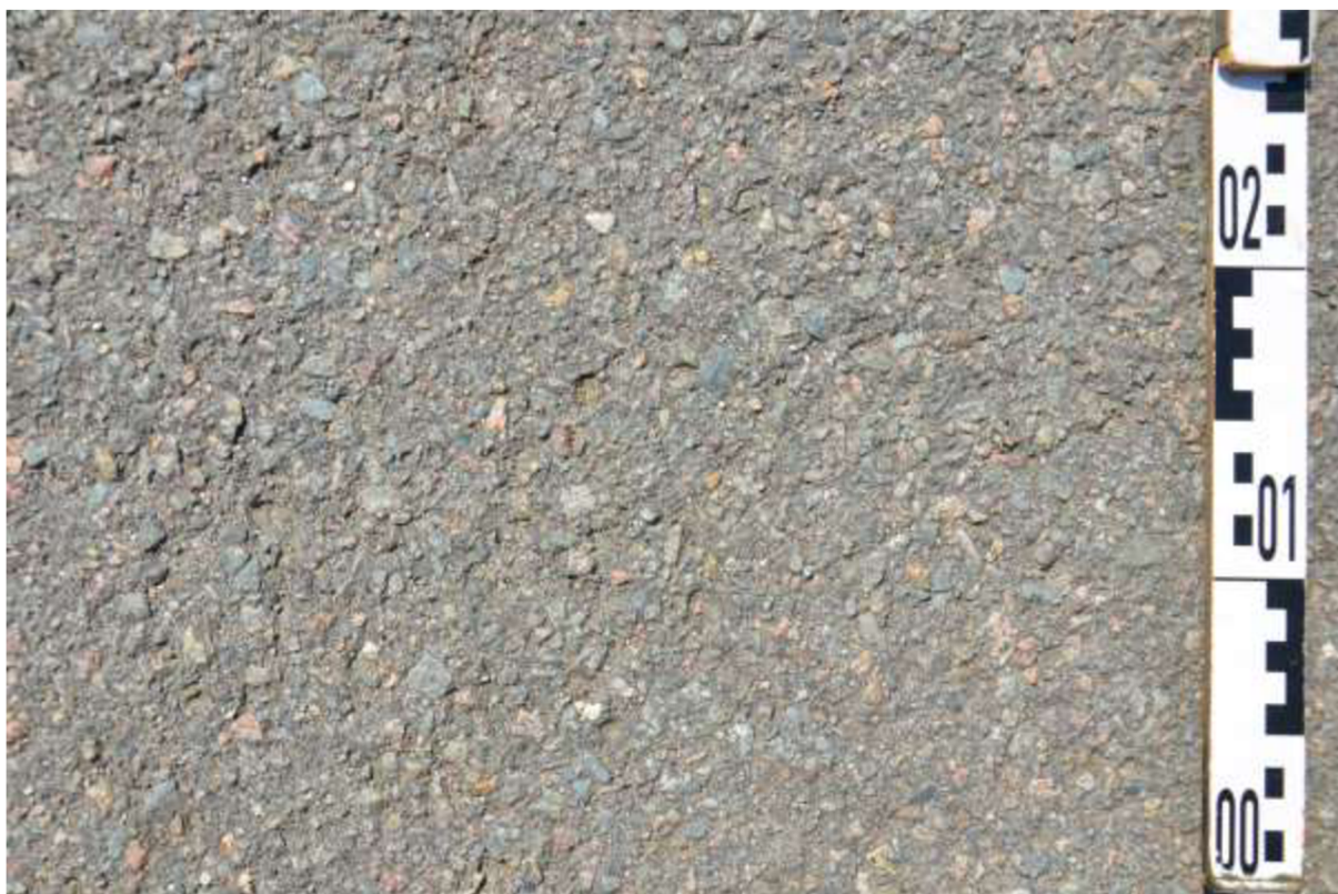
Obr. 17 Detail povrchu vozovky
