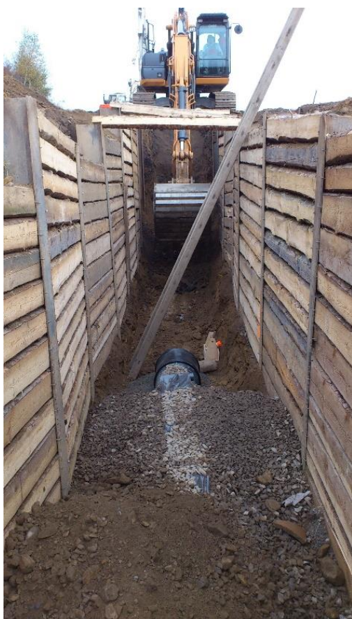
Příloha 12 Uložené drenážní potrubí u 2. etapy sanace odkaliště K1
