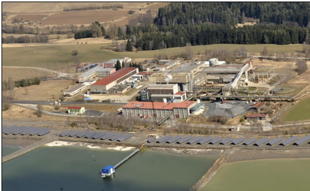
Příloha 5 Závod chemické úpravy (v popředí čerpací stanice technologických vod)
