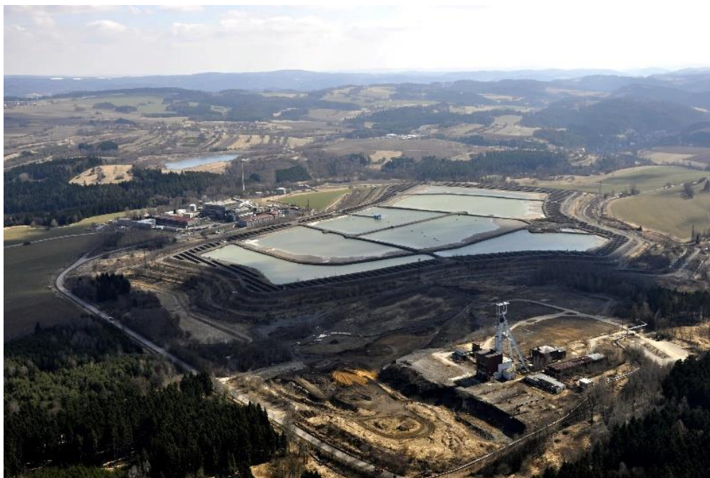
Příloha 3 Odkaliště K1 s chemickou úpravnou (v popředí likvidovaný důl R II – Jasan, v pozadí odkaliště K2)
