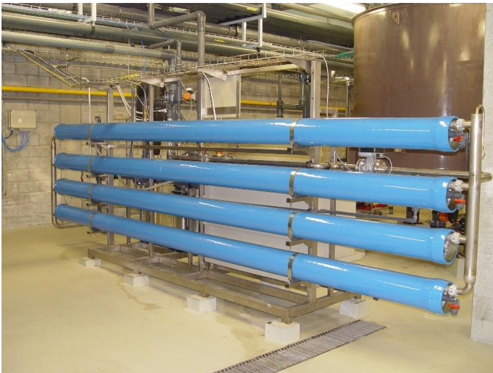
Příloha 8 Technologie čištění vod pomocí membránových procesů – reverzní osmóza
