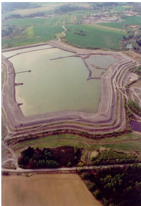
Příloha 2 Budování mezihrázek v Odkališti K1(1994)
