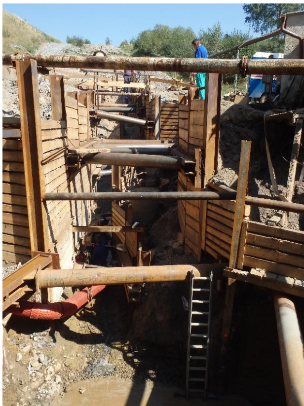
Příloha 13 Hloubení rýhy pro uložení drenážního systému pod hlavní hrází odkaliště K1
