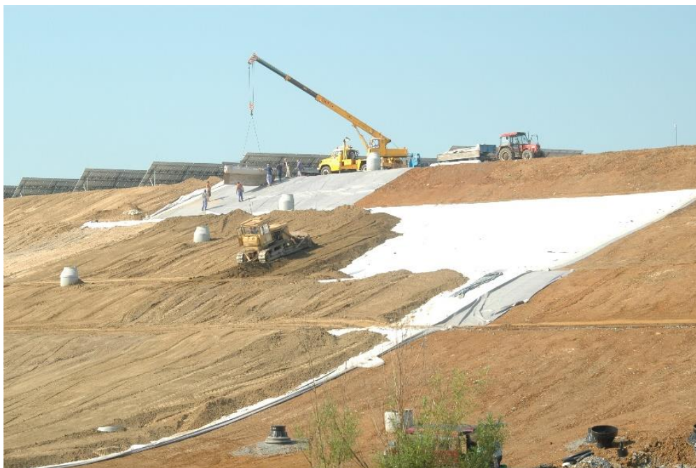
Příloha 11 Pokládání bentonitových rohoží a zakrytí zeminou u 1. etapy sanace odkaliště K1
