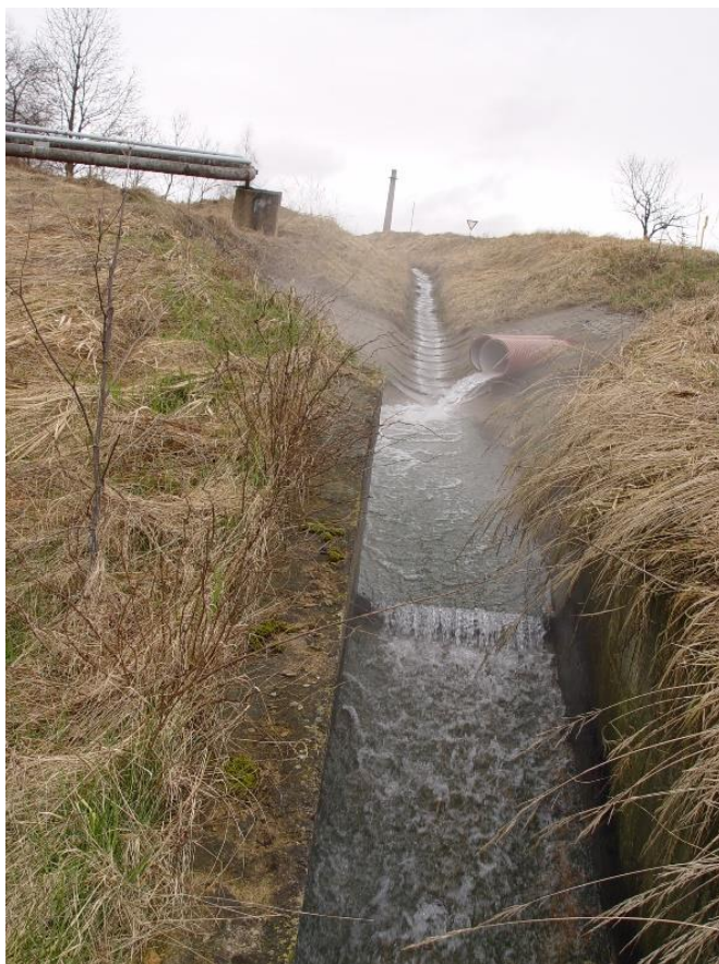
Příloha 6 Výpustný profil vyčištěných vod z CHÚ
