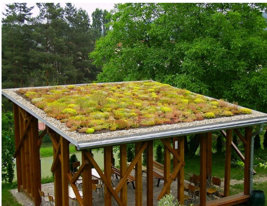
Obrázek 4: Extenzivní vegetační střecha (Greenville, 2013)
