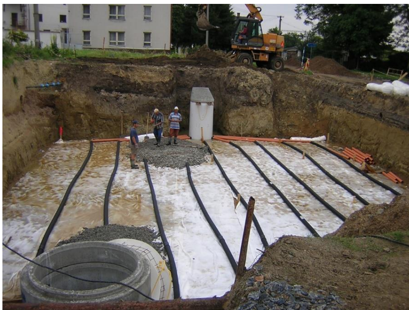
Obrázek 16: Podzemní vsakovací objekt vyplněný štěrčkem (Vacek, 2018)
