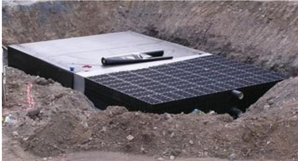
Obrázek 20: Podzemní retenční nádrž ve výstavbě (Samek, 2013).
