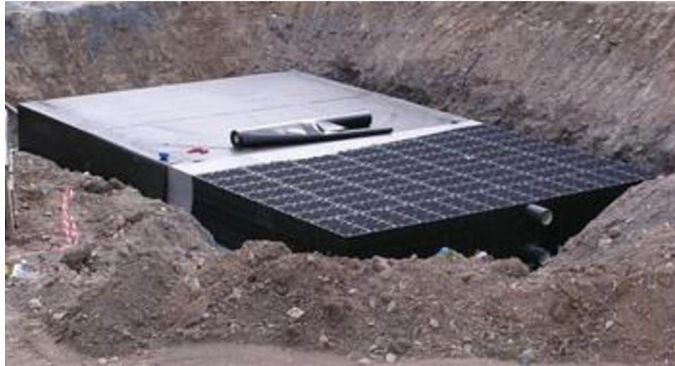
Obrázek 20: Podzemní retenční nádrž ve výstavbě (Samek, 2013).
