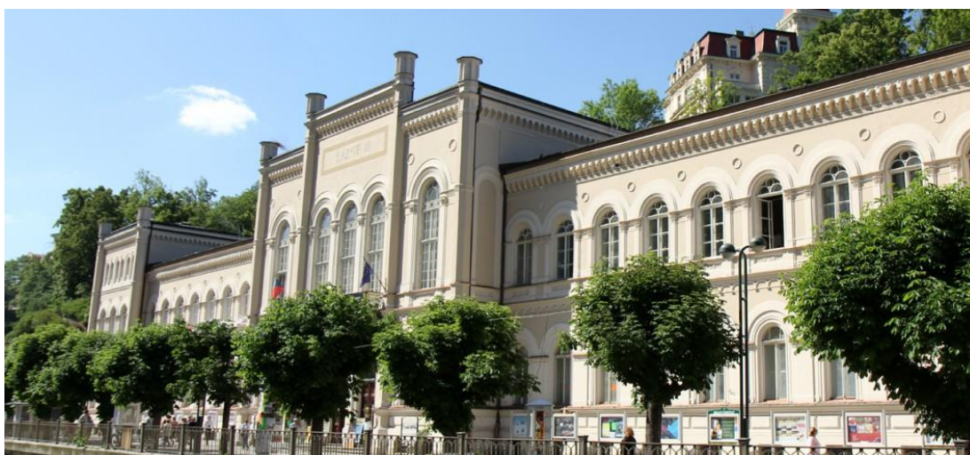
obr. 8 Budova Lázně III
