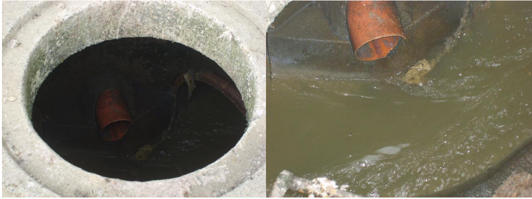
Obr. 6 a 7 – výtlač odpadních vod ze Staré Hutě + detail (zdroj vlastní)
