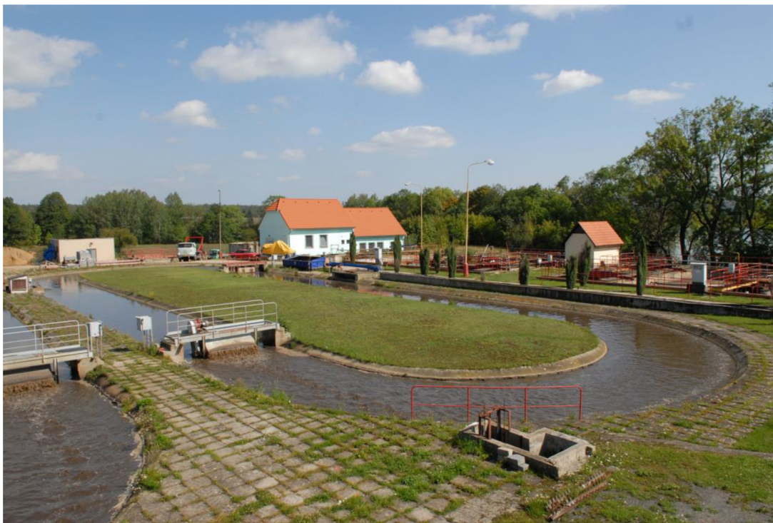
Obr. 4 – pohled na ČOV Dobříš před intenzifikací v roce 2009 (zdroj – VHS spol. s r.o. Dobříš)
