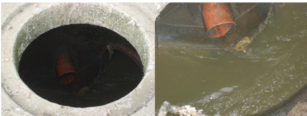
Obr. 6 a 7 – výtlač odpadních vod ze Staré Hutě + detail (zdroj vlastní)
