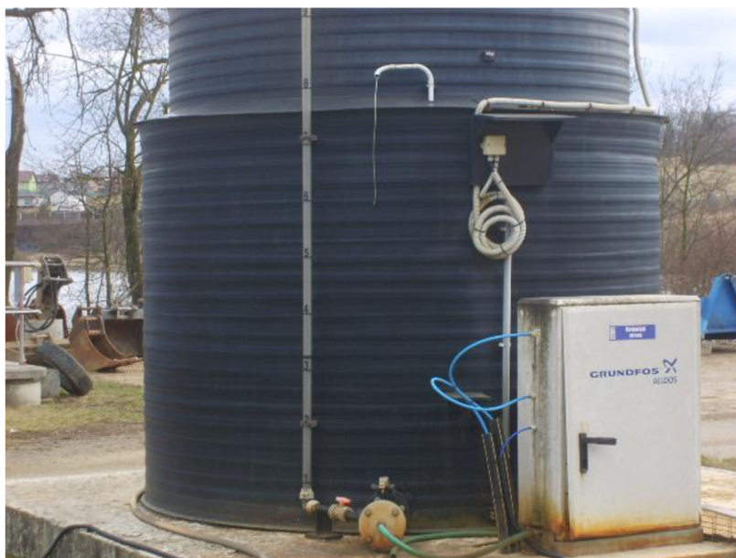
Obr. 18 – dávkovací stanice koagulantu (zdroj vlastní)
