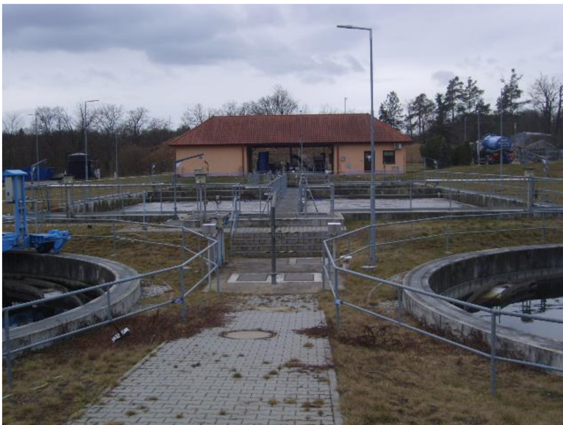
Obr. 21 – celkový pohled na ČOV Dobříš (zdroj vlastní)
