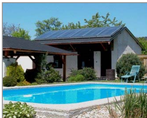
Obr. 28: Bazén vyhříváný plochými solárními kolektory [ 31]
