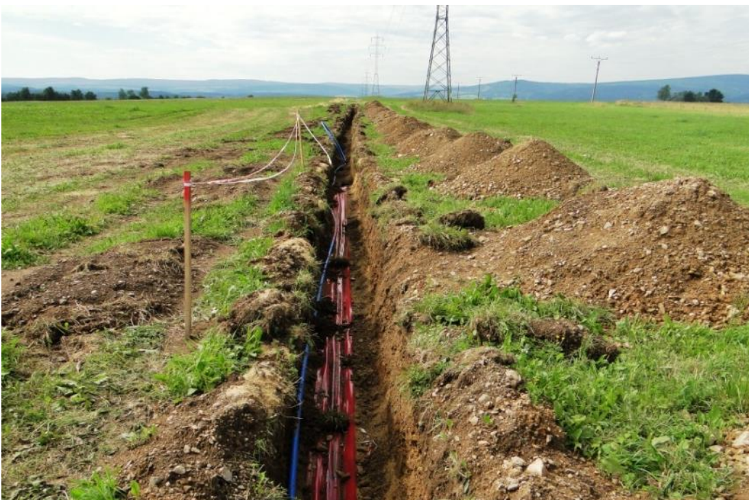
Obr. 13: Zemní práce za účelem uložení kabeláže (Mašková, 2010)
