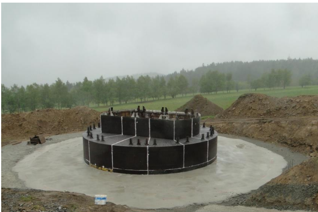
Obr. 14: Betonáž základových desek (Mašková, 2010)
