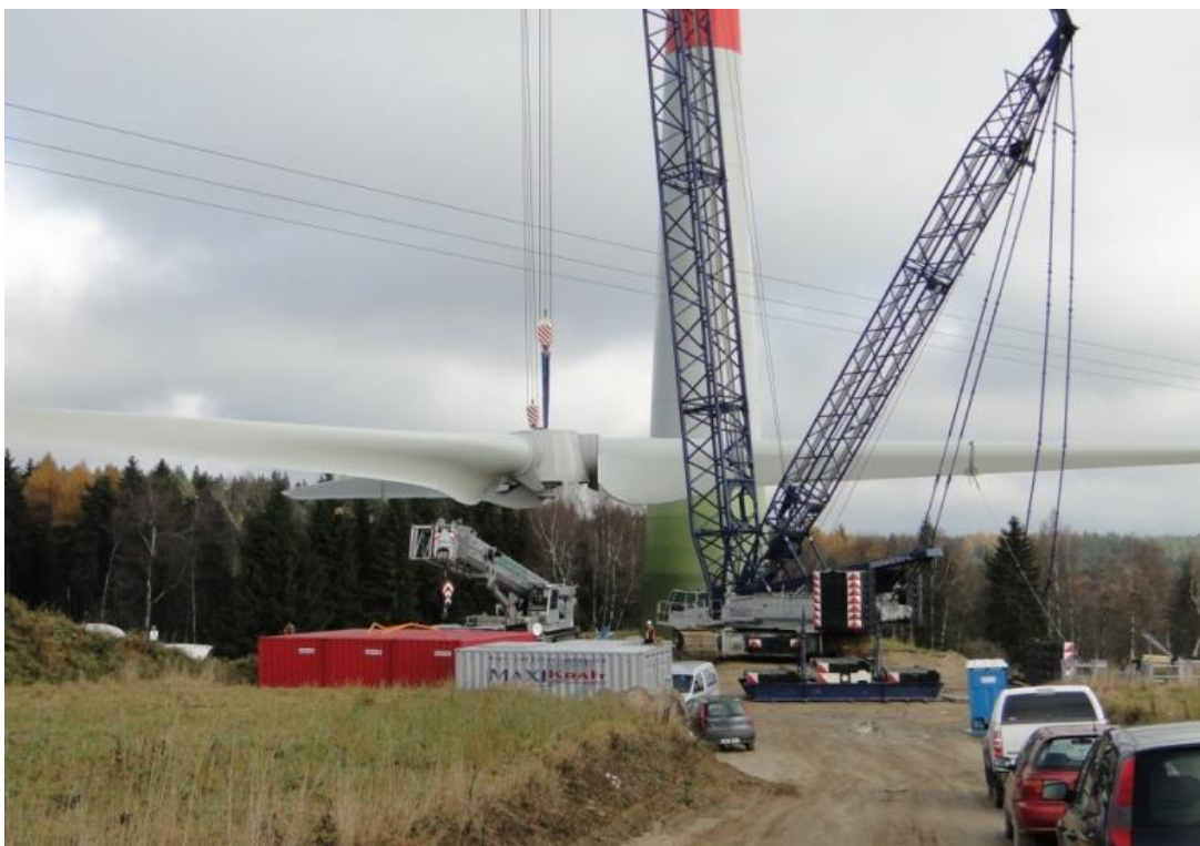
Obr. 17: Speciální montážní jeřáby při instalaci věží (Mašková, 2010)
