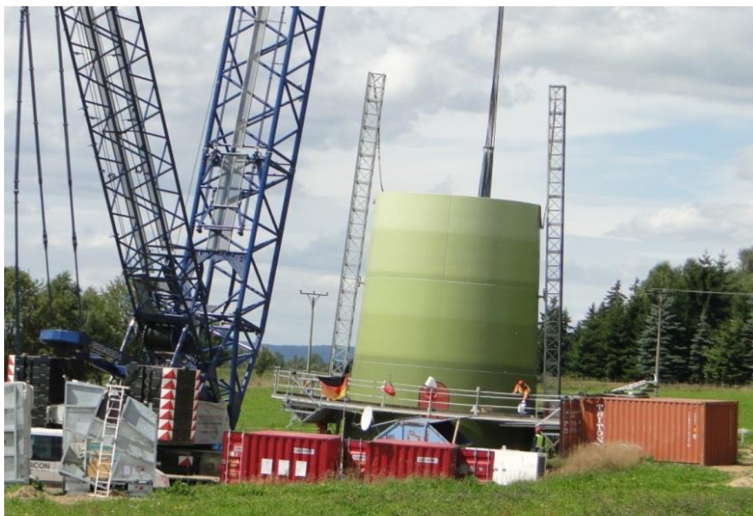
Obr. 16: Instalace věží, gondol a rotorů - pokračování (Mašková, 2010)
