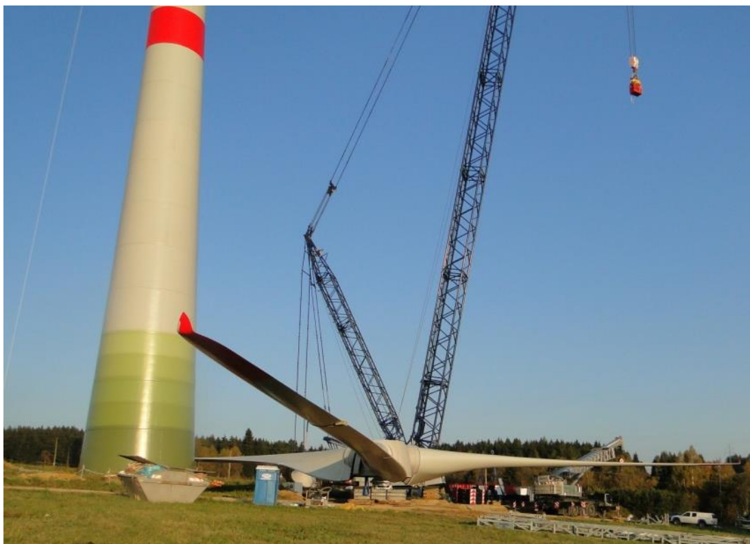
Obr. 15: Instalace věží, gondol a rotorů (Mašková, 2010)
