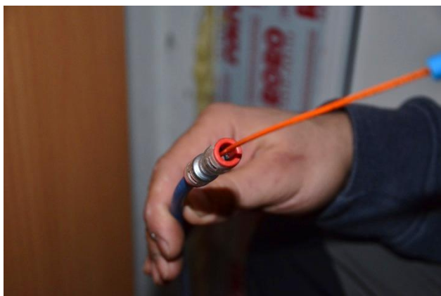
Obr.44- Technik ukazuje spojku dvou ochranných trubiček. Zdroj: archiv Eldata (fotografoval J.Prek)
