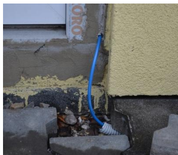
Obr.43- 4 vláknový kabel s ochranou vstupuje do objektu. Zdroj: archiv Eldata (fotografoval J.Prek)
