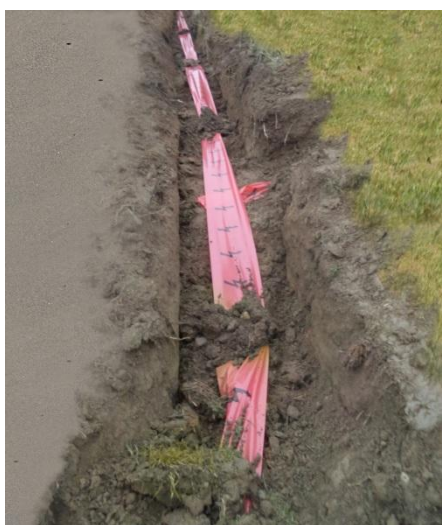
Obr.40- Výkop pro veřejné osvětlení v ulici Lidická v Jinočanech. Zdroj: archiv Eldata
