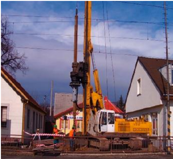
25 vrtná souprava CMV TH 15-50 www.geostav.cz
