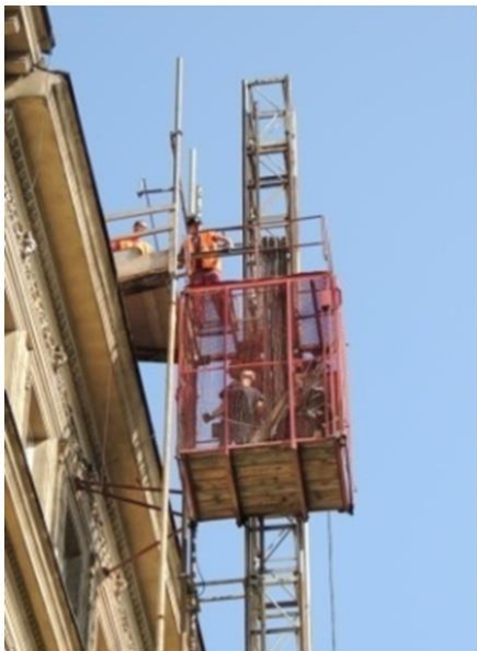
35 staveništní výtah NOV 650 www.technicorp.cz
