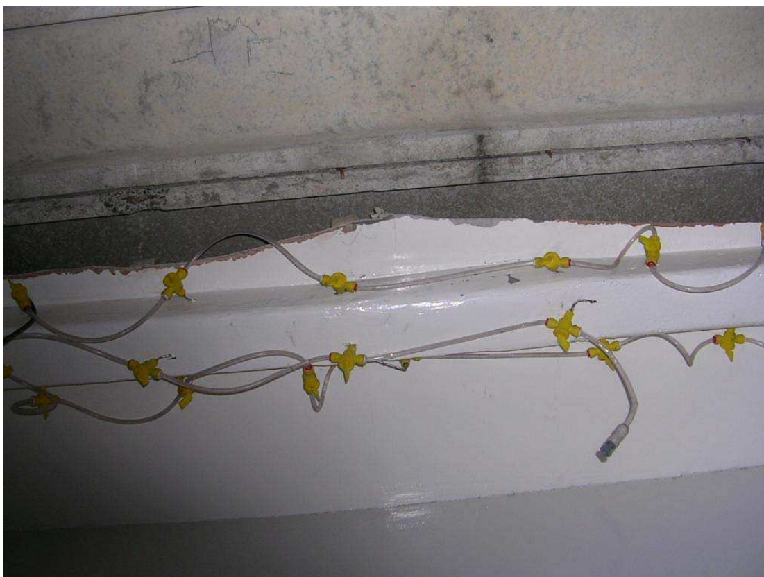
Obr. č. 11: Příklad navlhčení stříkané azbestové izolace pomocí vícebodové injektáže. (EVROPSKÁ KOMISE GŘ, 2006)
