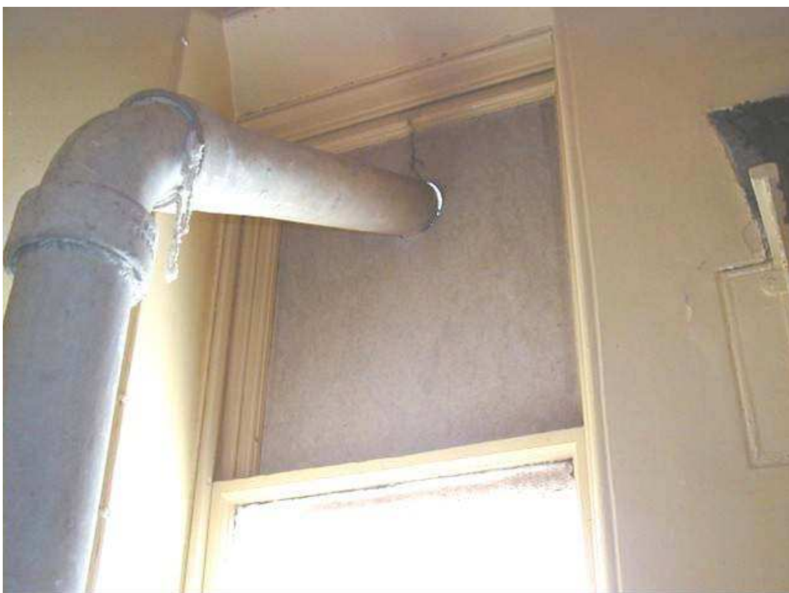
Obr. č. 20: Azbestocementová kouřová trubka s těsněním z azbestových provazců procházející azbestovým výplňovým panelem. (EVROPSKÁ KOMISE GŘ, 2006)
