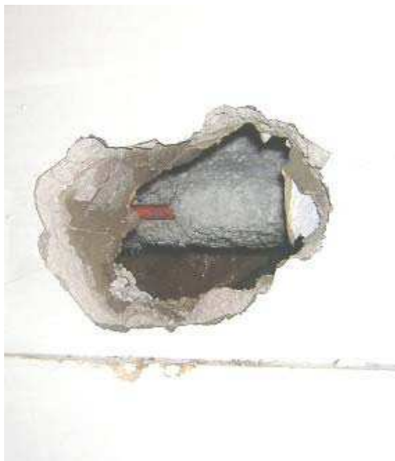
Obr. č. 21: Trubka s azbestovou izolací v částečně odkryté zdi. (EVROPSKÁ KOMISE GŘ, 2006)
