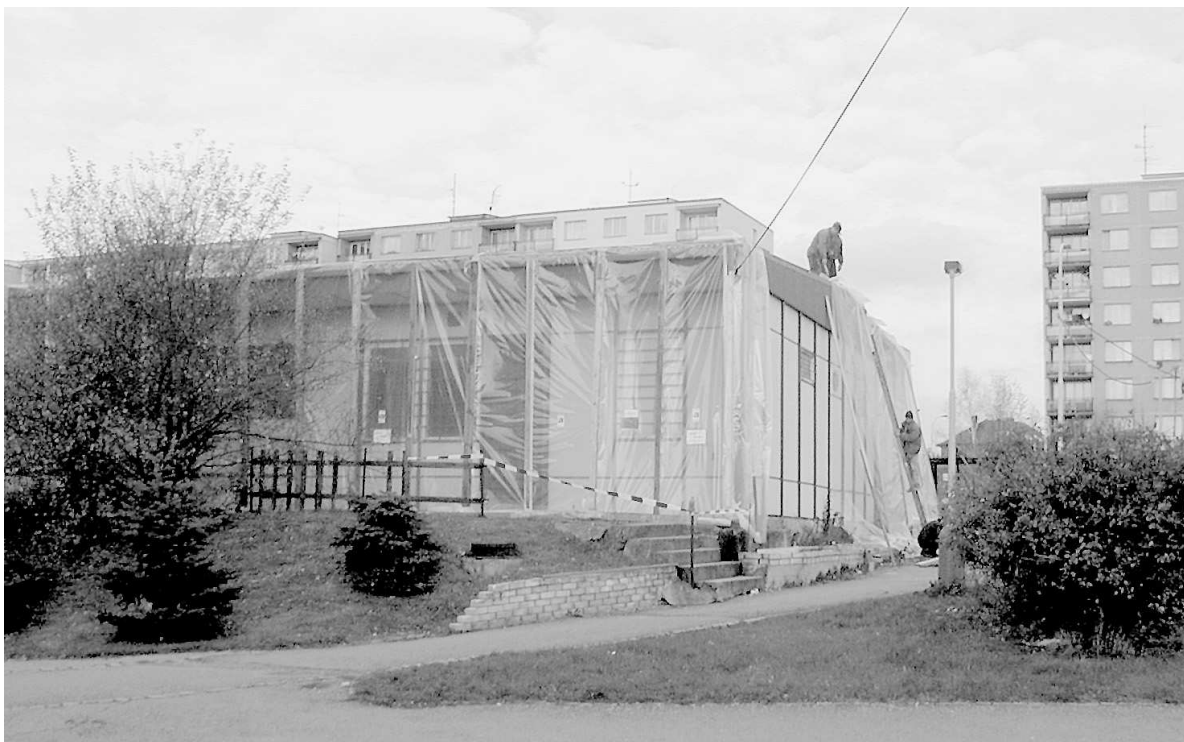
Obr. č. 32: Vytváření kontrolovaného pásma před likvidací azbestového nebezpečí v objektu. (Lutovská, Krch, 2005)
