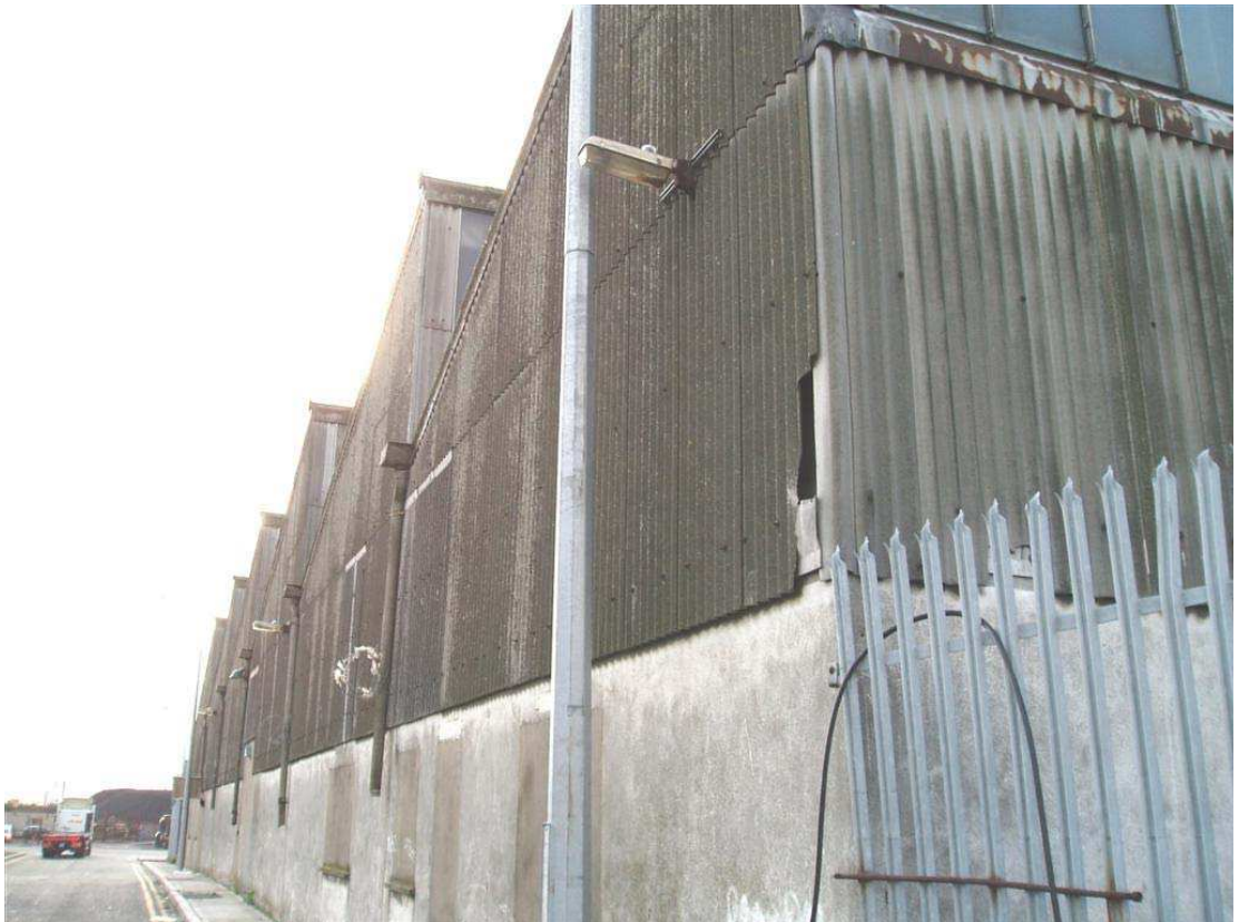
Obr. č. 15: Azbestocementový plášť tovární zdi. (EVROPSKÁ KOMISE GŘ, 2006)
