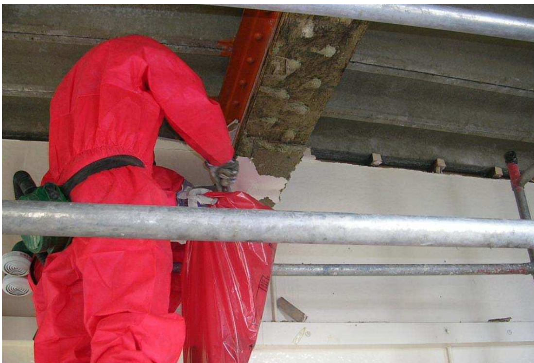
Obr. č. 24: Pytlování odpadu blízko místa odstraňování azbestu, aby se zamezilo šíření kontaminace a minimalizovala expozice. (EVROPSKÁ KOMISE GŘ, 2006)
