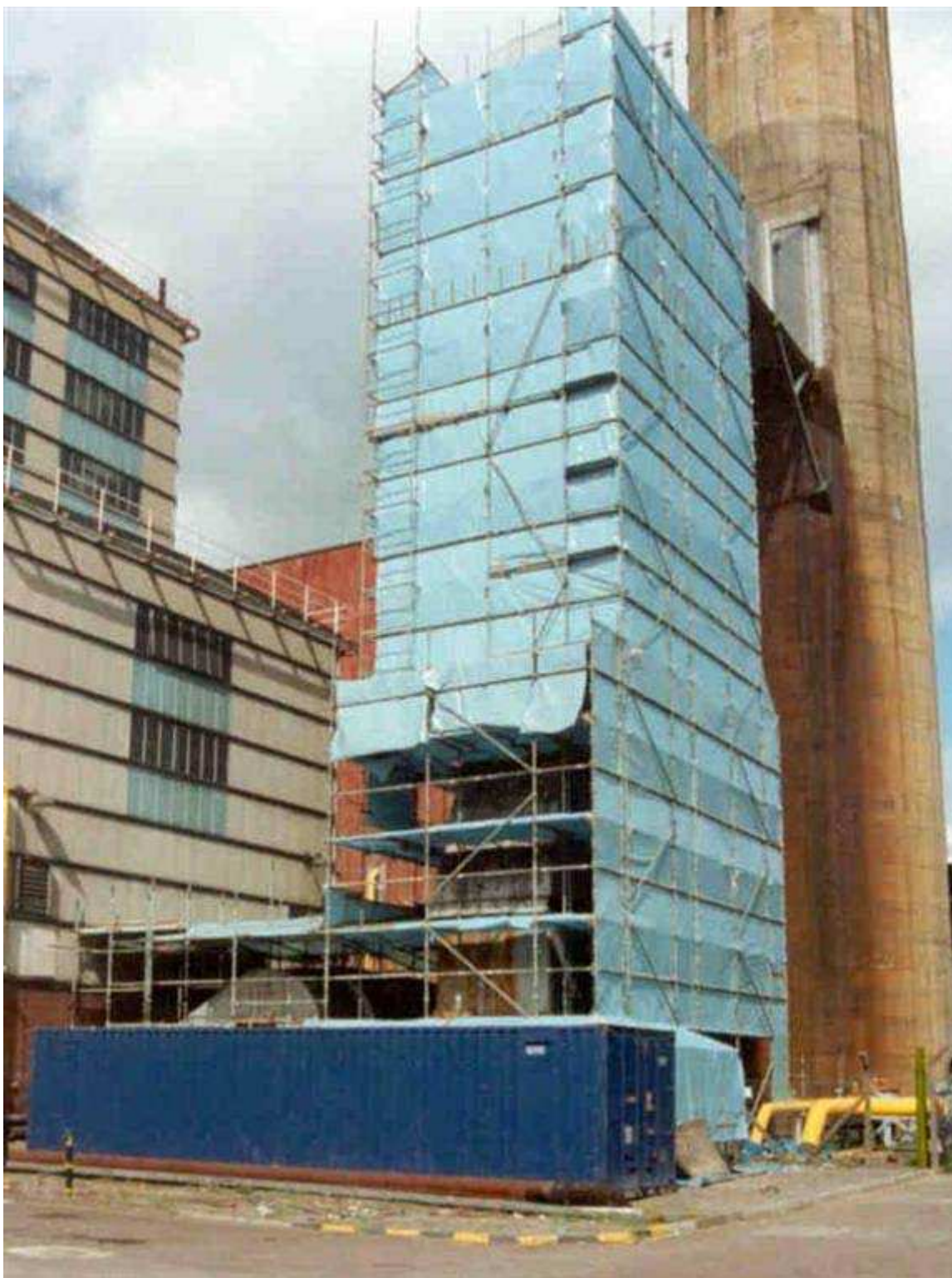
Obr. č. 27: Uzavřený prostor pro odstranění tepelné izolace z potrubí pro odvod spalin. (EVROPSKÁ KOMISE GŘ, 2006)
