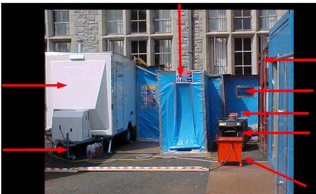
Obr. č. 26: Vstup do uzavřeného prostoru; šipky odshora po směru hodinových ručiček ukazují na: přechodovou komoru na pytle, kontejner na odpad, průzor, tlakoměr na měření podtlaku, podtlakovou jednotku, přívod elektřiny, zásobu smáčedel a dekontaminační jednotku. (EVROPSKÁ KOMISE GŘ, 2006)
