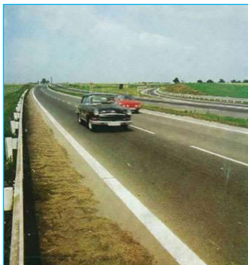
Obr. č. 7 Meziúrovňová křižovatka Koníčkův Mlýn na přeložce silnice I/7, ( http://www.komunikace-r7.cz )
