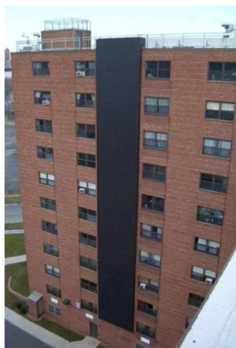
Obr. 5.21 Bytový dům Syracuse, New York (USA); [9]
