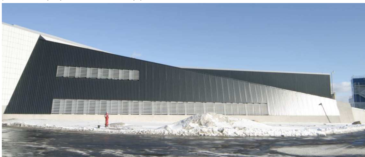
Obr. 5.10 Osvětlená část fasády je solární fasáda SolarWall® a v pozadí neperforovaný plech, Toronto (Kanada); [9]
