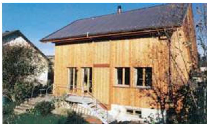
Obr. 5.39 Dům po sanaci, Horw (Švýcarsko); [4]
