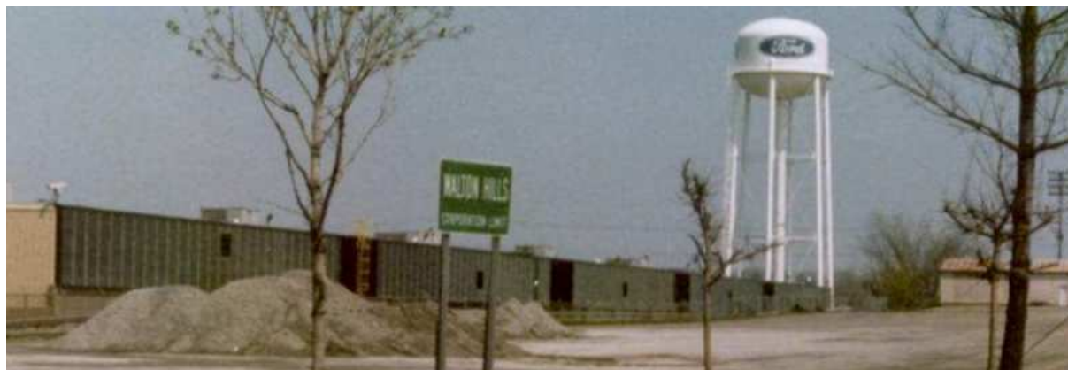
Obr. 5.30 Jedna ze 7 instalací pro Ford Motor Company na území Severní Ameriky, Cleveland (USA); [9]
