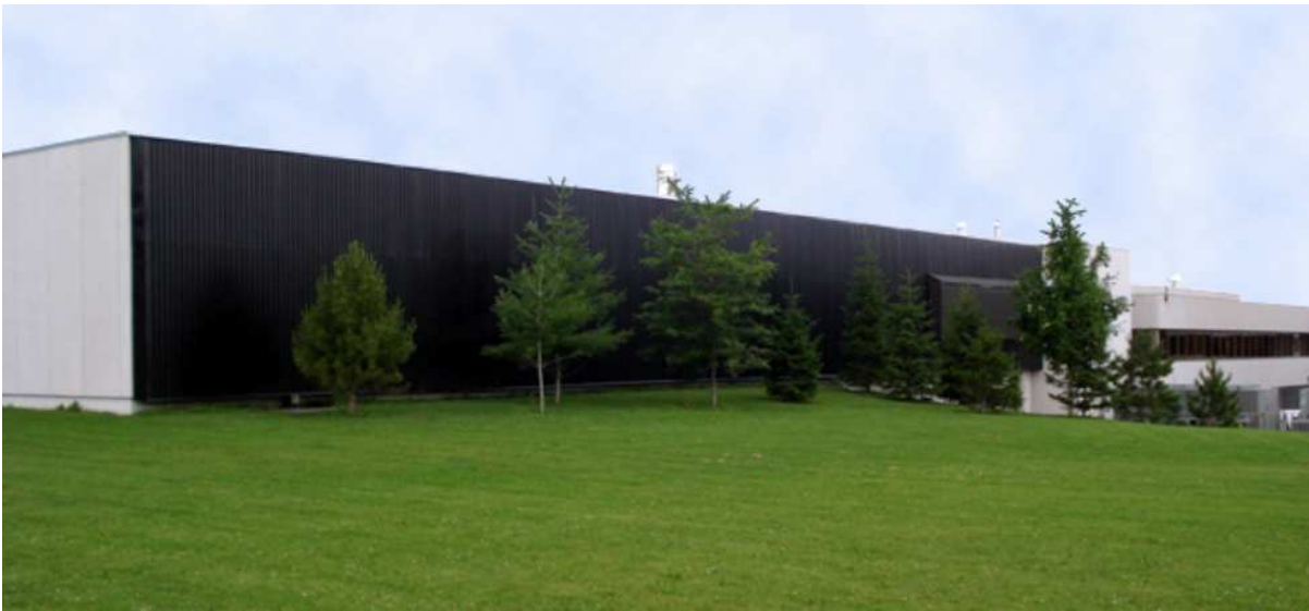
Obr. 5.6 Jihozápadní stěna pobočky MDS Nordion, Ottawa (Kanada); [9]
