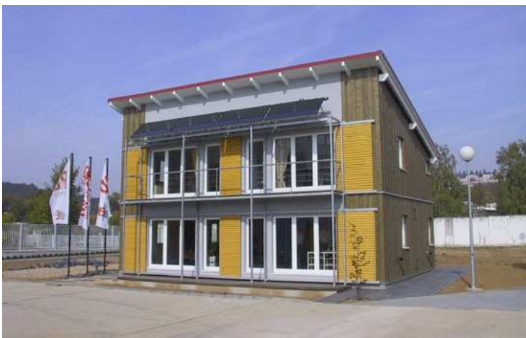
Obr. 5.47 Nízkoenergetický dům Kubis, Brno (ČR); [6]
