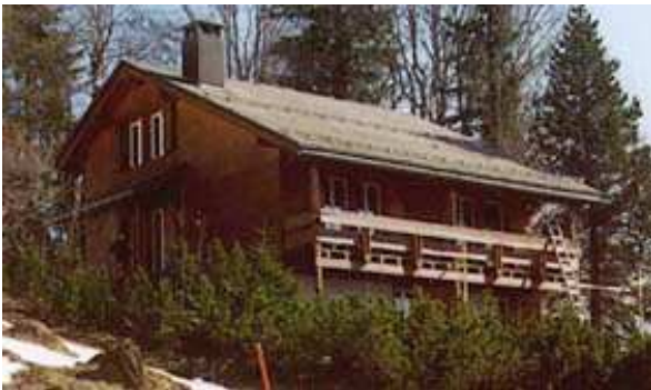
Obr. 5.40 Dům z roku 1965 před rekonstrukcí, Braunwald (Švýcarsko); [4]
