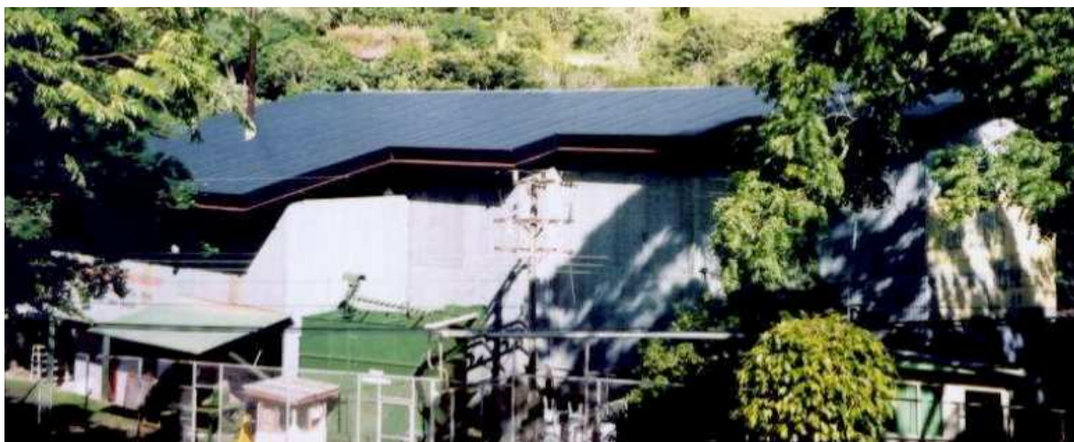
Obr. 5.33 Panely SolarWall® pokrývají střechu sušárny kávy, Coopeldos (Kostarika); [9]
