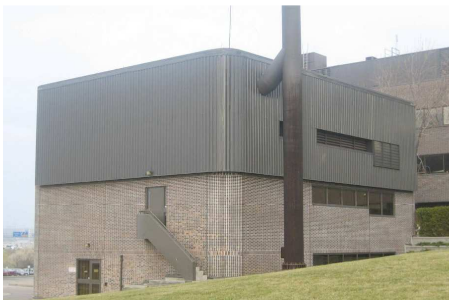
Obr. 5.22 Budova laboratoře komplexu Health Canada, Toronto (Kanada); [9]
