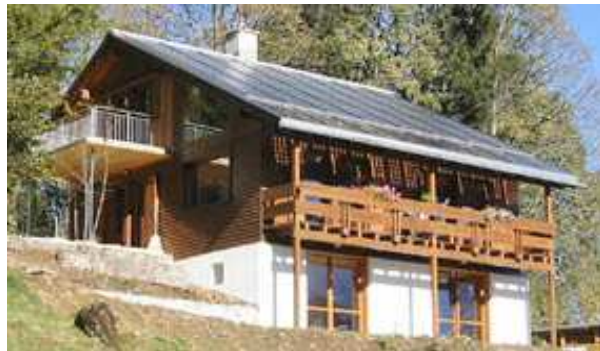
Obr. 5.41 Dům po přestavbě, Braunwald (Švýcarsko); [4]
