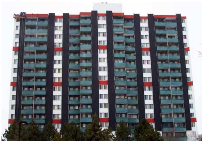
Obr. 5.7 Černé vertikální a červené horizontální kolektory SolarWall® na bytovém domě, Ottawa (Kanada); [9]
