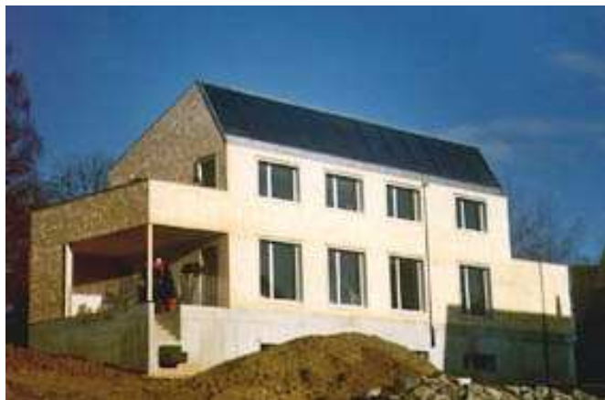
Obr. 5.42 Tmavá plocha kolektoru na střeše domu, Degersheim (Švýcarsko); [4]
