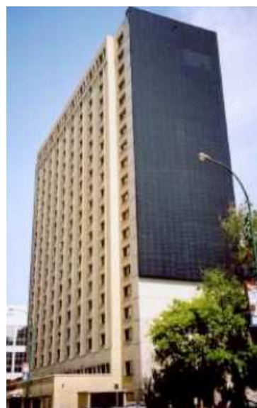
Obr. 5.25 MHA po instalaci systému, Manitoba (Kanada); [9]
