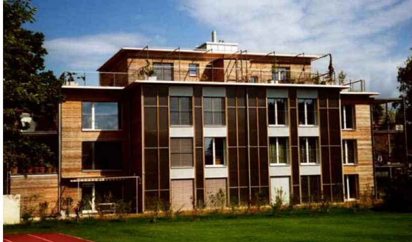
Obr. 5.35 Pasivní dům s fasádním otevřeným kolektorovým systémem, Winterthur (Švýcarsko); [4]
