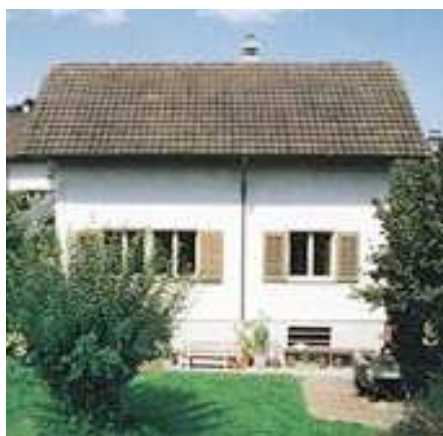
Obr. 5.38 Dům z roku 1945 před rekonstrukcí, Horw (Švýcarsko); [4]
