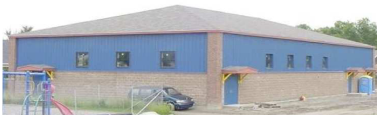
Obr. 5.23 Tělocvična s modrými panely, Thetford (USA); [9]
