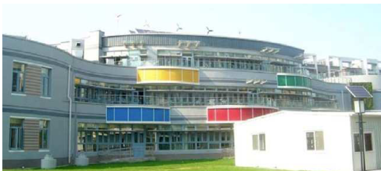
Obr. 5.31 Objekt v olympijské vesničce s horizontálním šedým kolektorem SolarWall ® (na střeše je pak SolarWall PV/T ™ ), Peking (Čína); [9]
