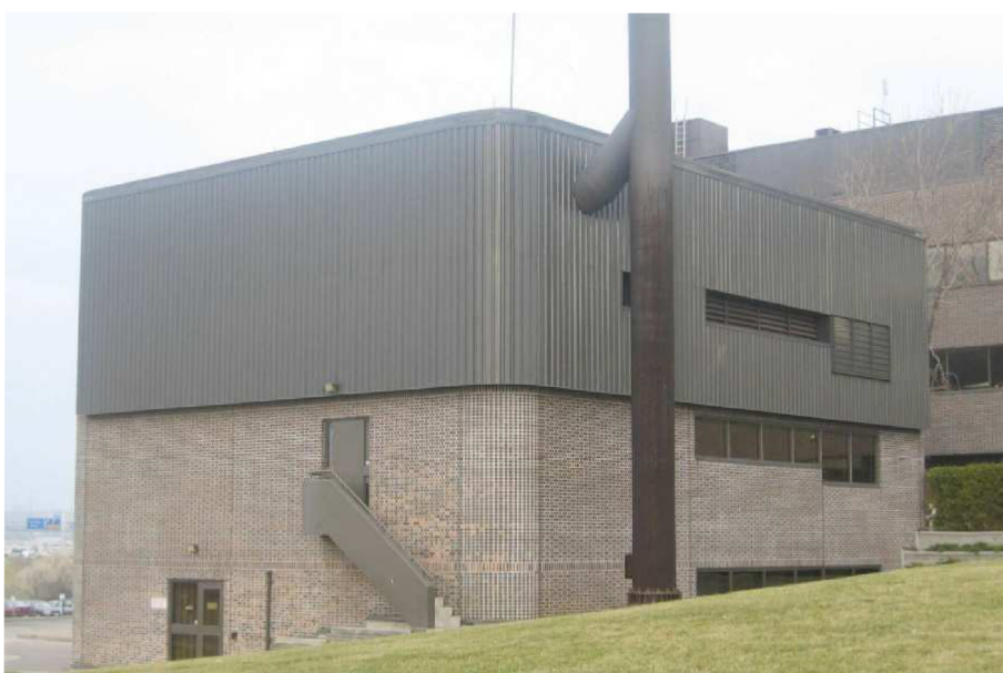
Obr. 5.22 Budova laboratoře komplexu Health Canada, Toronto (Kanada); [9]
