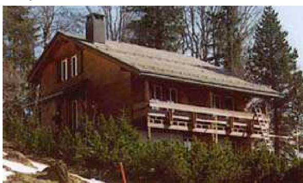
Obr. 5.40 Dům z roku 1965 před rekonstrukcí, Braunwald (Švýcarsko); [4]
