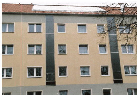
Obr. 5.45 Panelový dům s vertikálně uspořádanými kolektory na fasádě a horizontálně na střeše, Friedland (Německo); [7]
