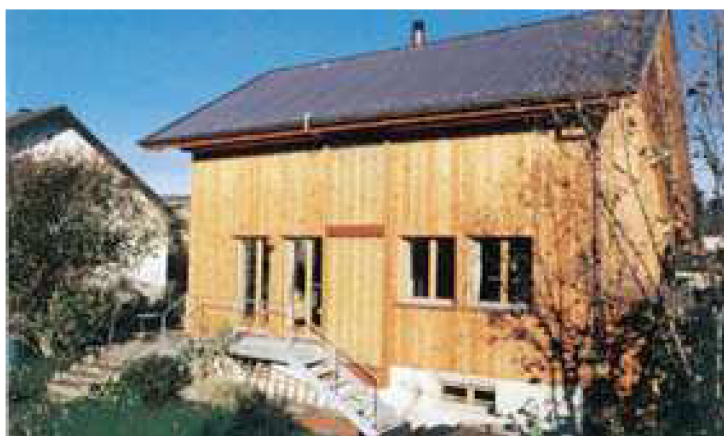
Obr. 5.39 Dům po sanaci, Horw (Švýcarsko); [4]
