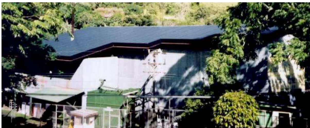
Obr. 5.33 Panely SolarWall® pokrývají střechu sušírny kávy, Coopeldos (Kostarika); [9]
