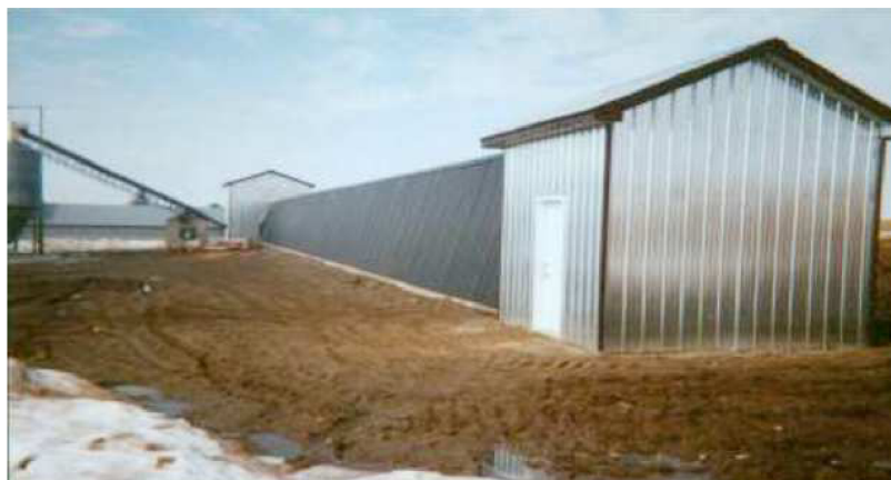
Obr. 5.34 Systém SolarWall® spojující dva světlé objekty na Gelee Chicken Farm, Sherbrooke (Kanada); [9]
