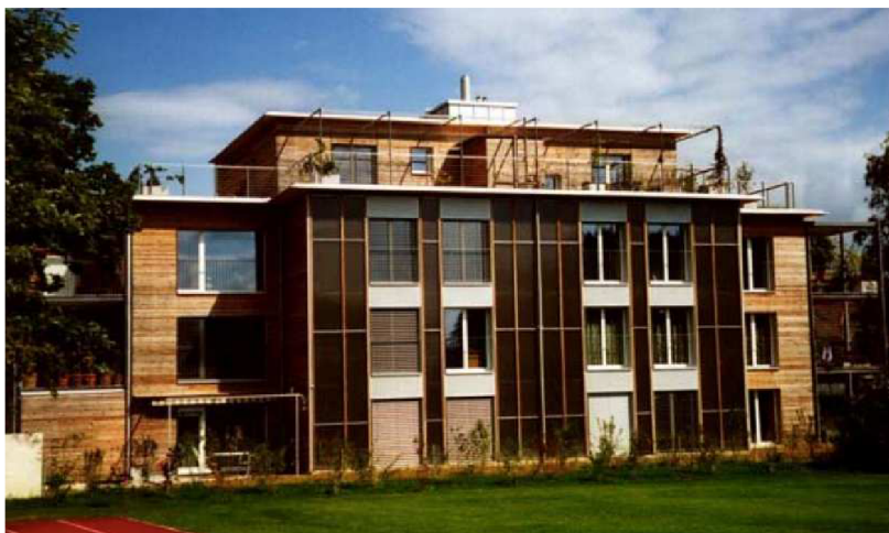
Obr. 5.35 Pasivní dům s fasádním otevřeným kolektorovým systémem, Winterthur (Švýcarsko); [4]
