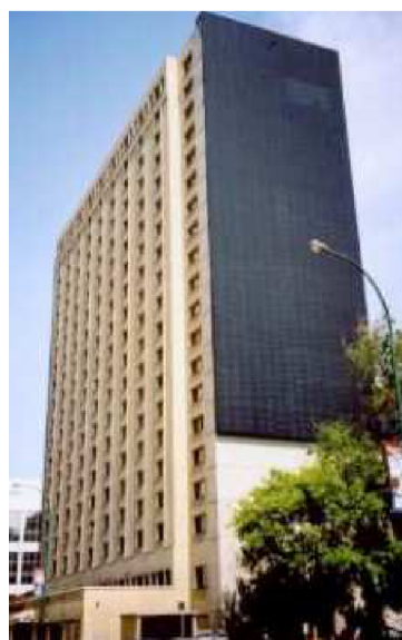
Obr. 5.25 MHA po instalaci systému, Manitoba (Kanada); [9]
