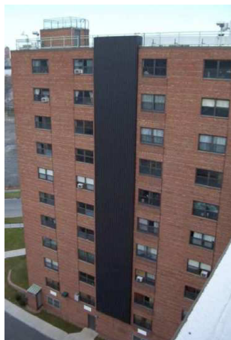
Obr. 5.21 Bytový dům Syracuse, New York (USA); [9]
