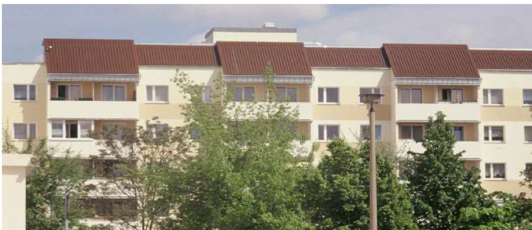
Obr. 5.15 Použití systému SolarWall® na střechu obytné budovy, Wiwog (Německo); [9]
