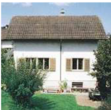
Obr. 5.38 Dům z roku 1945 před rekonstrukcí, Horw (Švýcarsko); [4]
