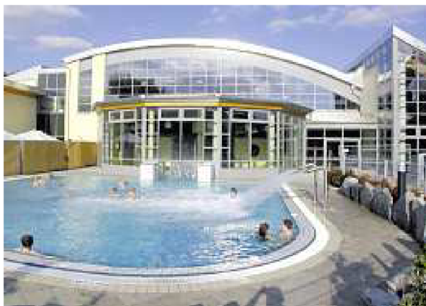
Obr. 5.46 Využití vzduchových kolektorů u velkého sportovního komplexu, Laatzen (Německo); [2]
