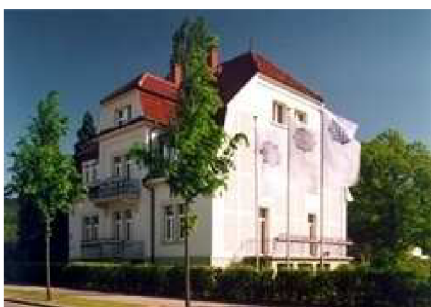
Obr. 2.5 Vila Tannheim, Freiburg (Německo); [12]
