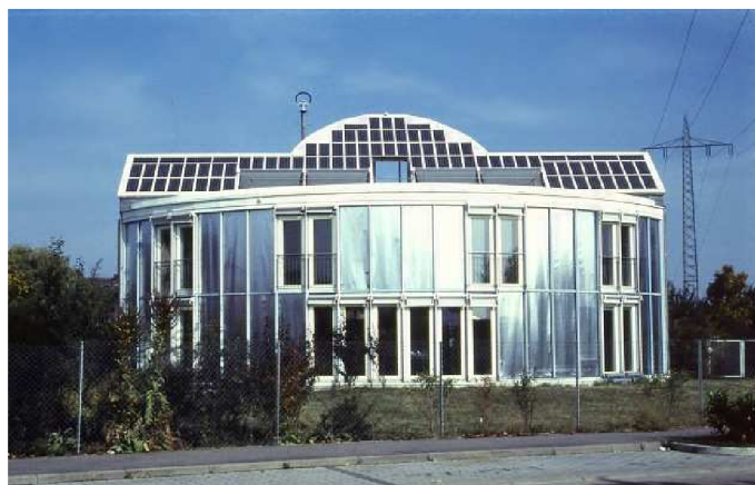
Obr. 2.3 Reflexní rolety na Trombeho stěně domu Nullenergyhouse, Freiburg (Německo); [3]
