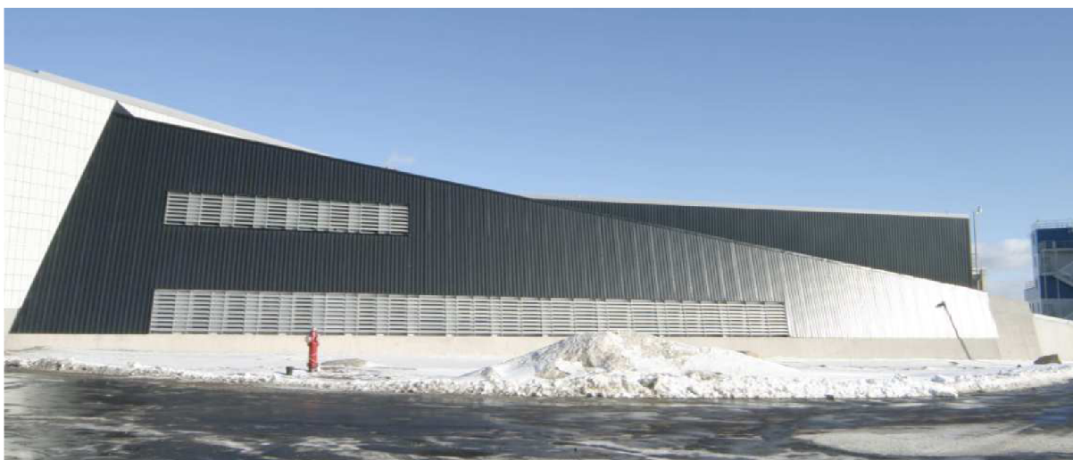
Obr. 5.10 Osvětlená část fasády je solární fasáda SolarWall® a v pozadí neperforovaný plech, Toronto (Kanada); [9]
