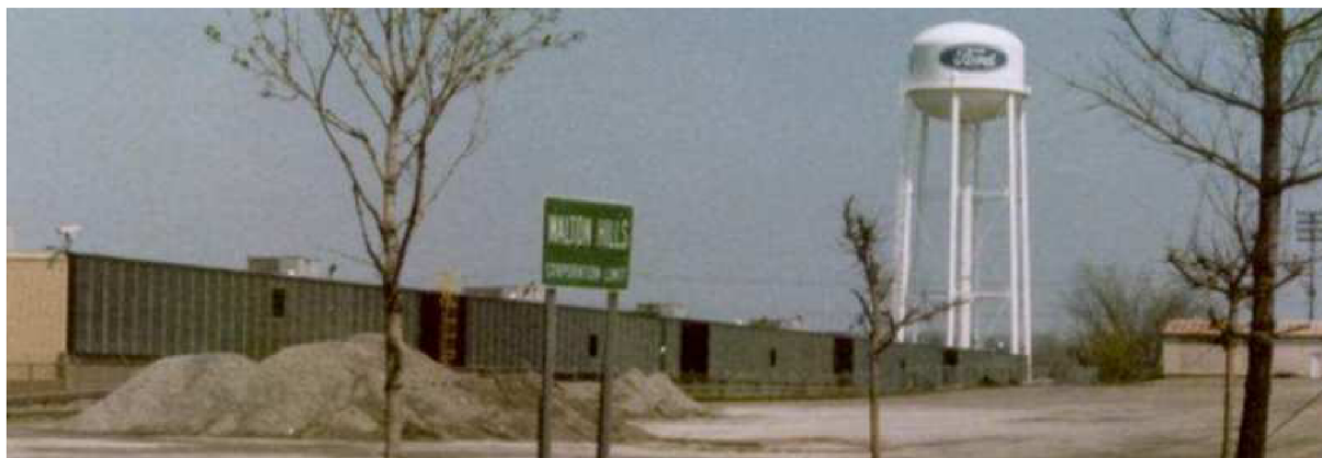
Obr. 5.30 Jedna ze 7 instalací pro Ford Motor Company na území Severní Ameriky, Cleveland (USA); [9]
