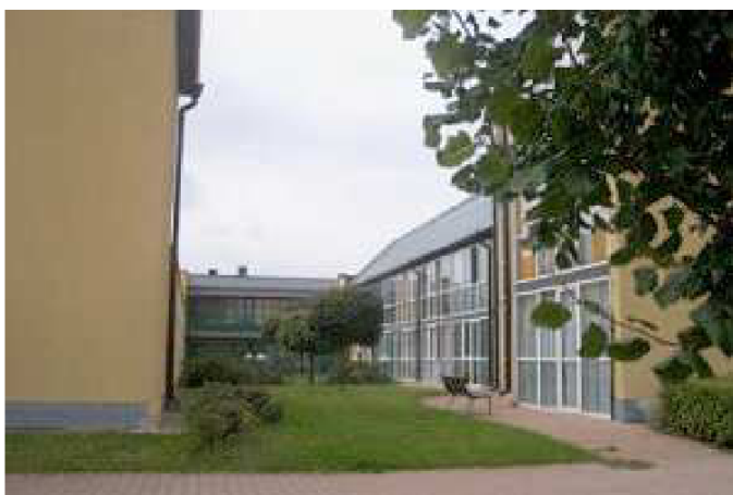
Obr. 5.52 Nižší z budov komplexu Slunečního penzionu (v pozadí západní propojující objekt), Svitavy (ČR); [13]
