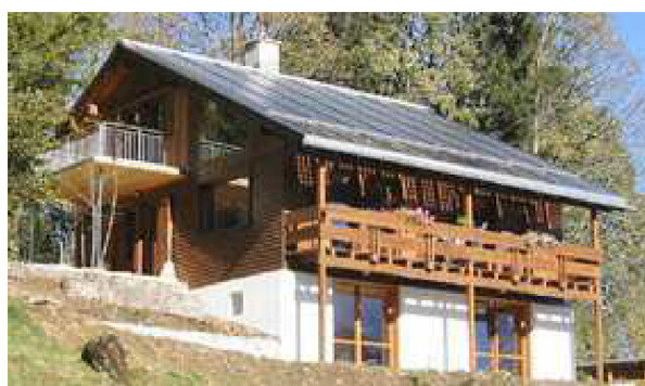
Obr. 5.41 Dům po přestavbě, Braunwald (Švýcarsko); [4]
