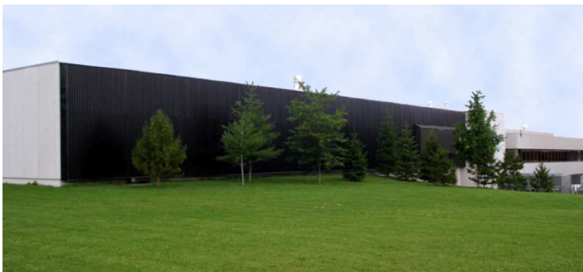
Obr. 5.6 Jihozápadní stěna pobočky MDS Nordion, Ottawa (Kanada); [9]
