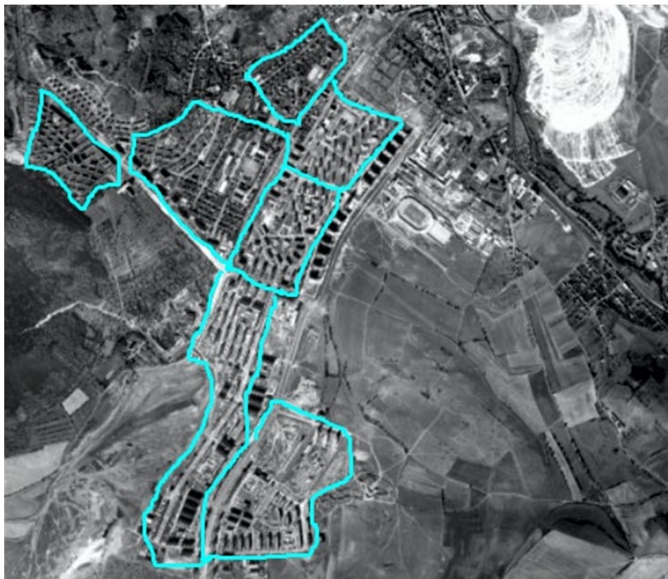
Obrázek 11: Ortofotomapa Mostu 1964 (Ministerstvo vnitra ČR - VGHMÚř Dobruška - Publikováno na mapovém serveru města Mostu) zakreslena nová zástavba 1. - 4. obvodu
