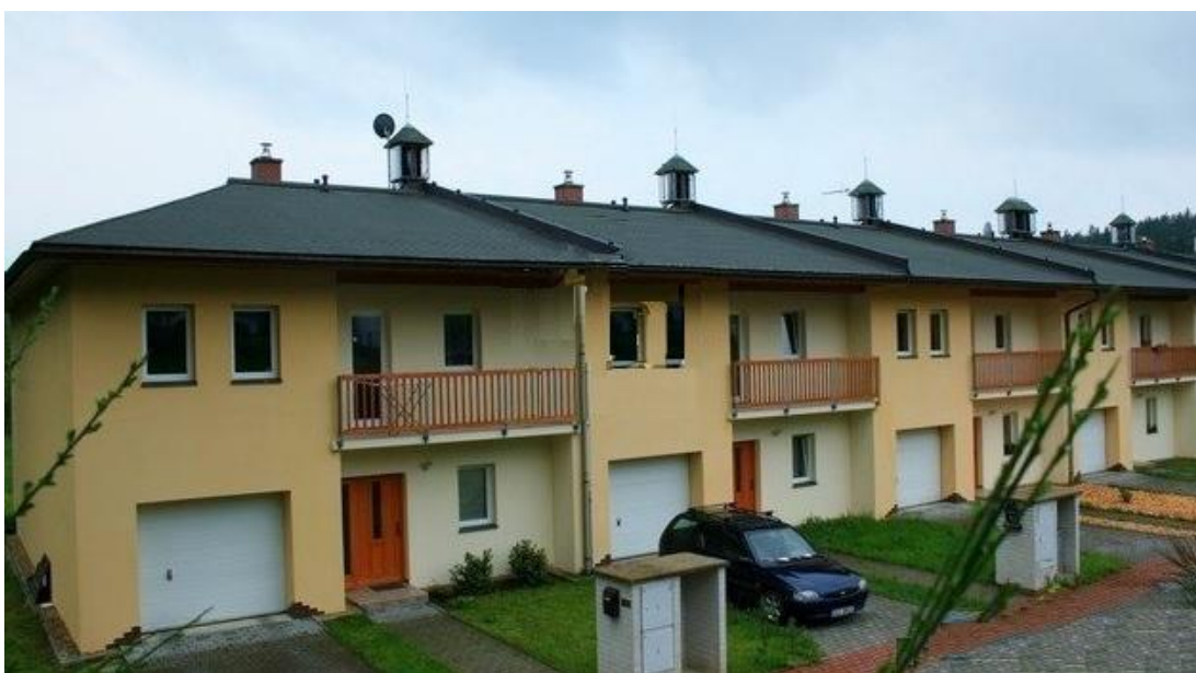
Foto číslo 13 – Nízkoenergetické řadové domy v Nejdku (ORP Karlovy Vary)
