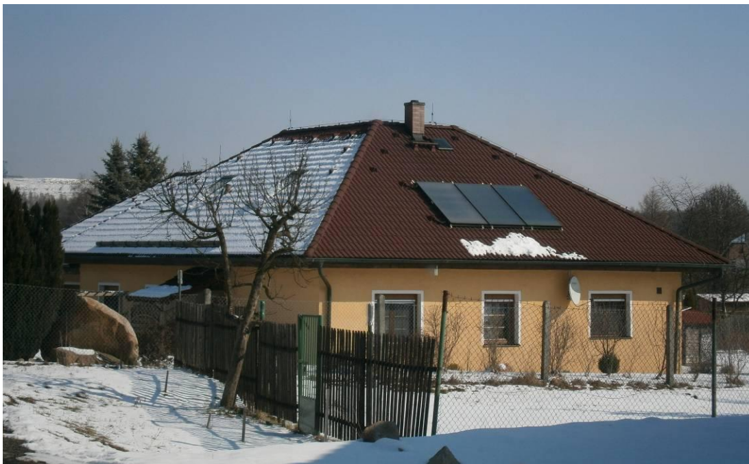
Foto číslo 10 – Nízkoenergetický dům ve Staré Chodovské čp. 117 (ORP Sokolov)
