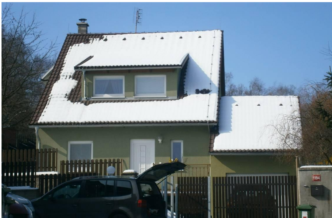
Foto číslo 2 – Pasivní dům v Chodově čp 1194 (ORP Sokolov)
