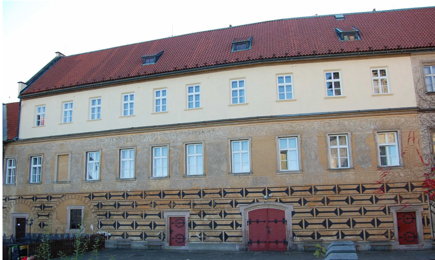
9. Dlouhé jihozápadní křídlo zámku Hrubá Skála, pohled z vnitřního nádvoří.
