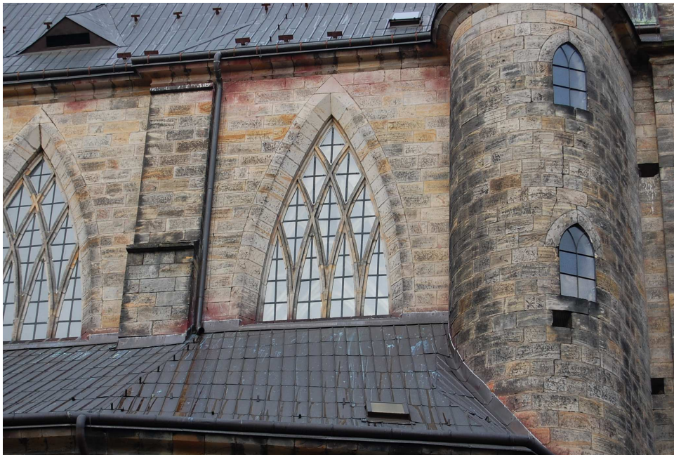
30. Detail okna hlavní lodě chrámu Narození Panny Marie v Turnově.
