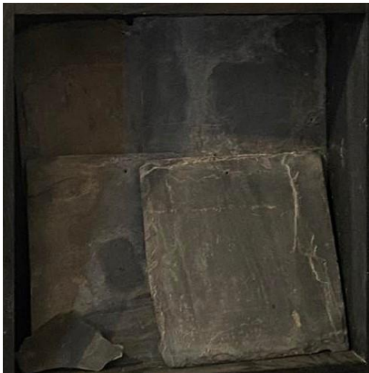
Příloha č. 5: Kamenná střešní krytina (Autor: Jakub Raclavský)
