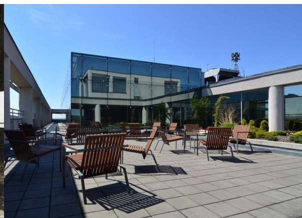
obr. 8 Střecha Baťova mrakodrapu dnes
