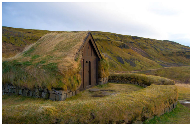
obr. 2 Skandinávská zelená střecha
