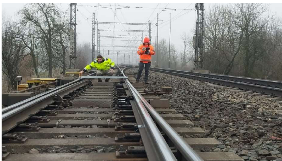
Obr. 11: Měření osy kolejí
