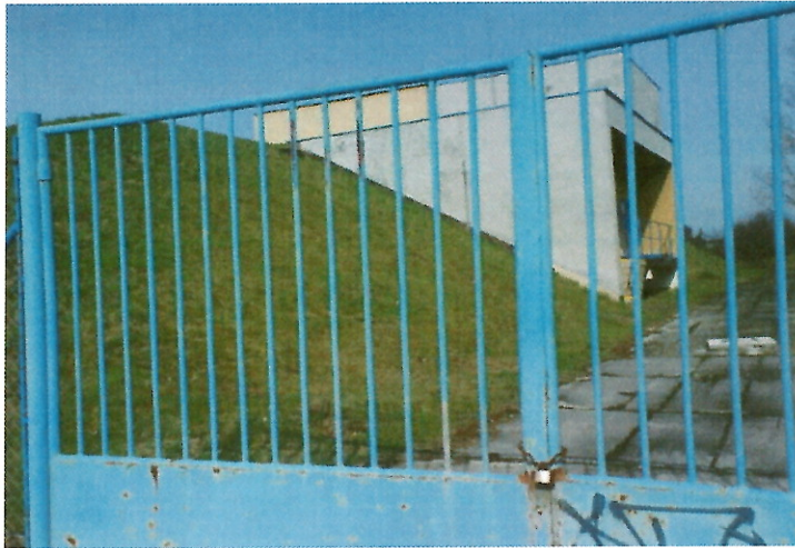
Obr. 6: Objektu vodojemu - Ořešák
