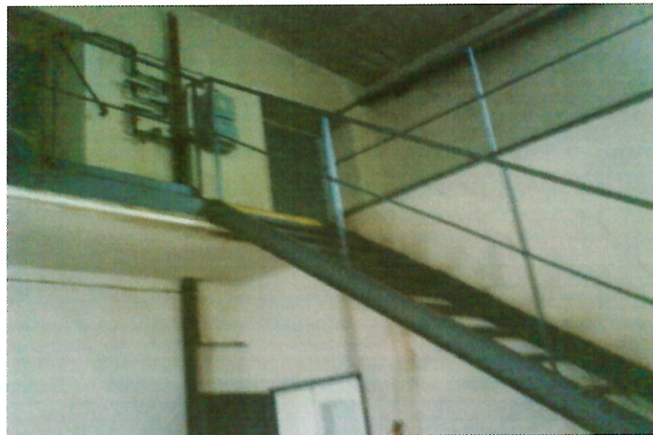
Obr. 7: Objektu vodojemu - Ořešák
