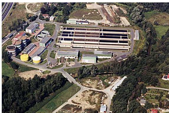
Obr. 2: Úpravna vody Souš v Libereckém kraji
