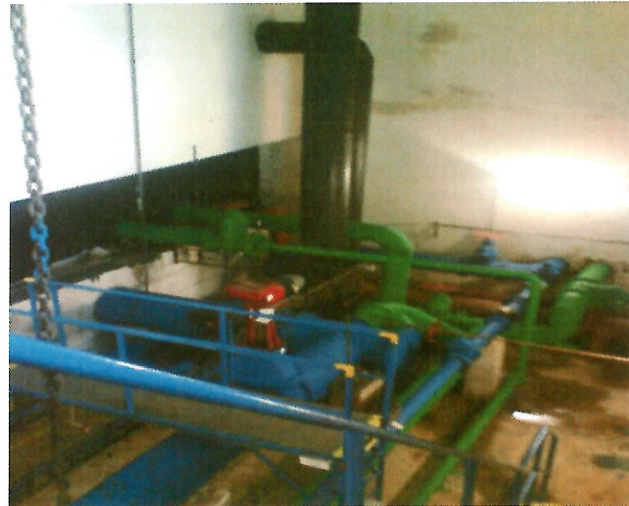
Obr. 10: Objekt vodojemu – vnitřní část
