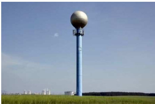
Obr. 3: Nadzemní vodojem poblíž jaderné elektrárny Dukovany
