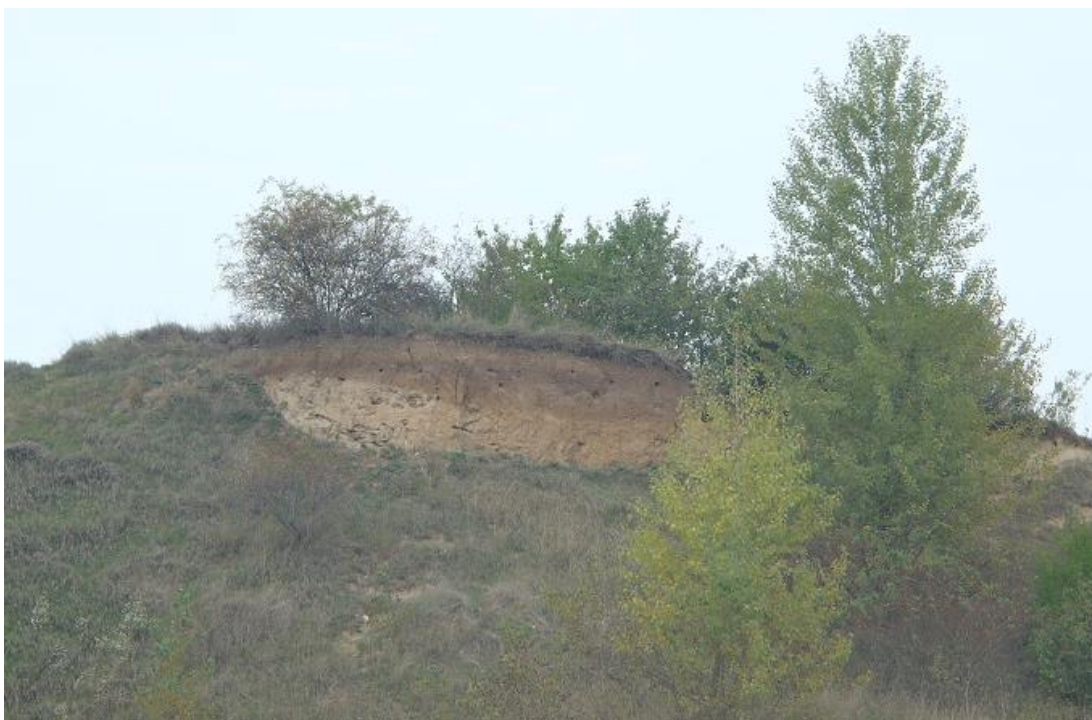
Příloha č. 17 – Ponechaná strmá stěna z dob těžby v lokalitě Jeviněves. Zdroj: autorka
