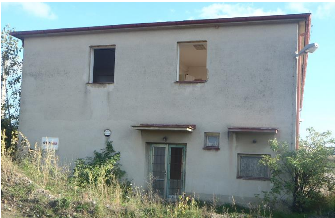
Příloha č. 4 – Opuštěná a chátrající administrativní budova náležící k bývalé pískovně v Lužci nad Vltavou. Budovu občasně obývají bezdomovci.
