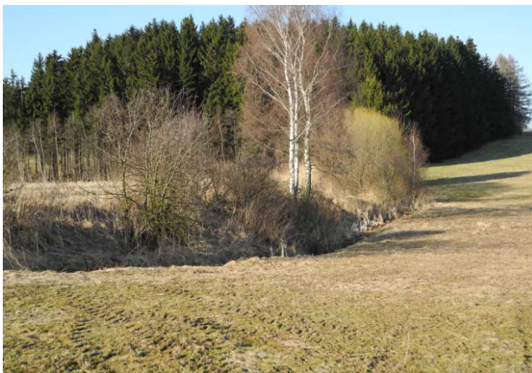
Příloha F. Hráz nádrže (autor)
