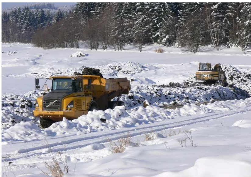
Obrázek 25. Práce dampru a pásového rypadla při těžbě sedimentu ( www.aquasys.cz )
