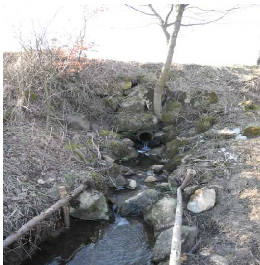
Obrázek 17. Odpadní potrubí (autor)
