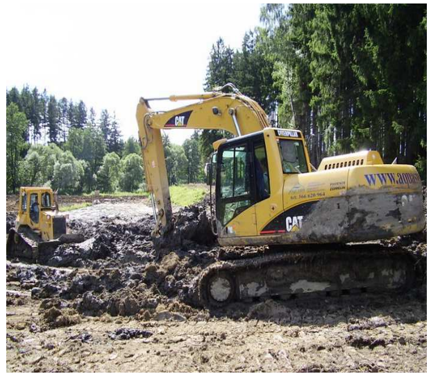
Obrázek 12. Těžba sedimentu suchou cestou ( www.aqasys.cz )
