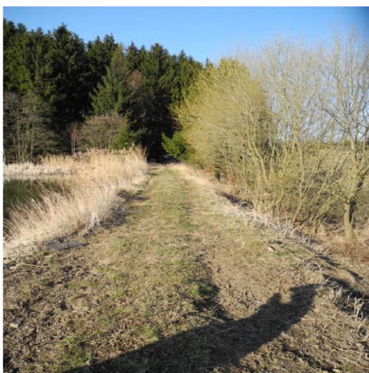
Obrázek 16. Hráz nádrže (autor)
