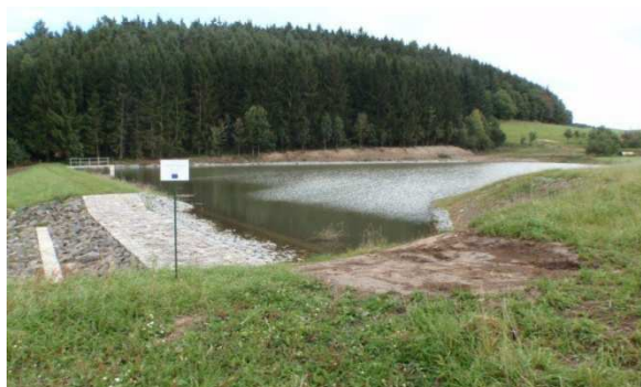
Obrázek 6. Čelní bezpečnostní přeliv ( www.senea.cz )
