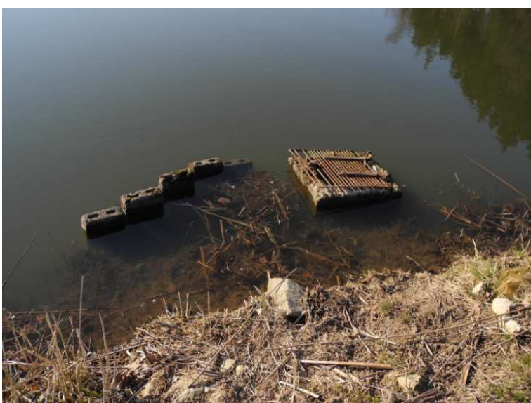
Příloha G. Výpusť nádrže (autor)
