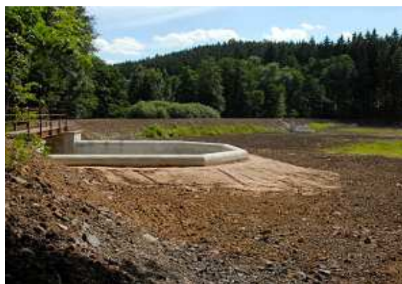
Obrázek 7. Kašnový bezpečnostní přeliv ( www.rybarstvi-litomysl.cz )
