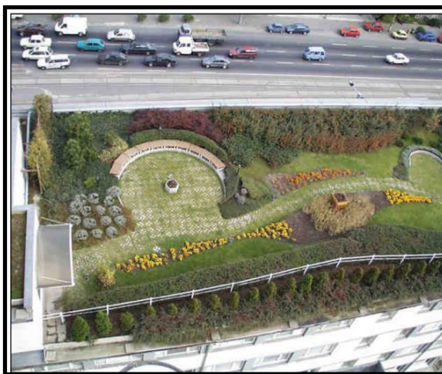
Obr. 3 – příklad zelené střechy (DEKTRADE, 2009).
