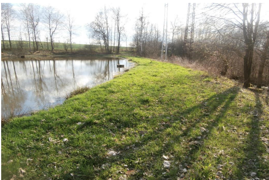
Obr. 30 Hráz MVN Dolní rybník na Špici
