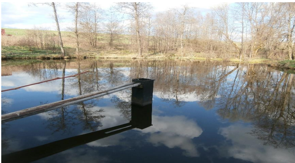
Obr. 33 Výpustné zařízení (Požerák) MVN Historický rybník Jindřichovice
