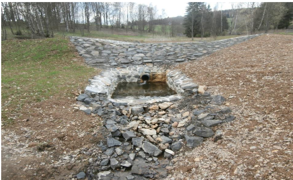
Obr. 41 Vyústění potrubí MVN Panský rybník II.
