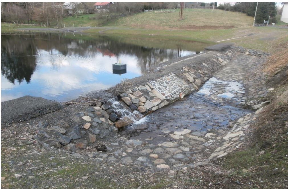
Obr. 37 Hráz, vypouštěcí potrubí a otevřený průleh MVN Panský rybník I.
