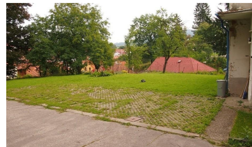
Obrázek 41: Travobetonová plocha na místě bývalého parteru
