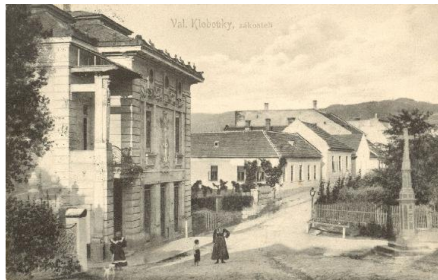
Obrázek 31: Bratmannova vila, pohled od kostela
