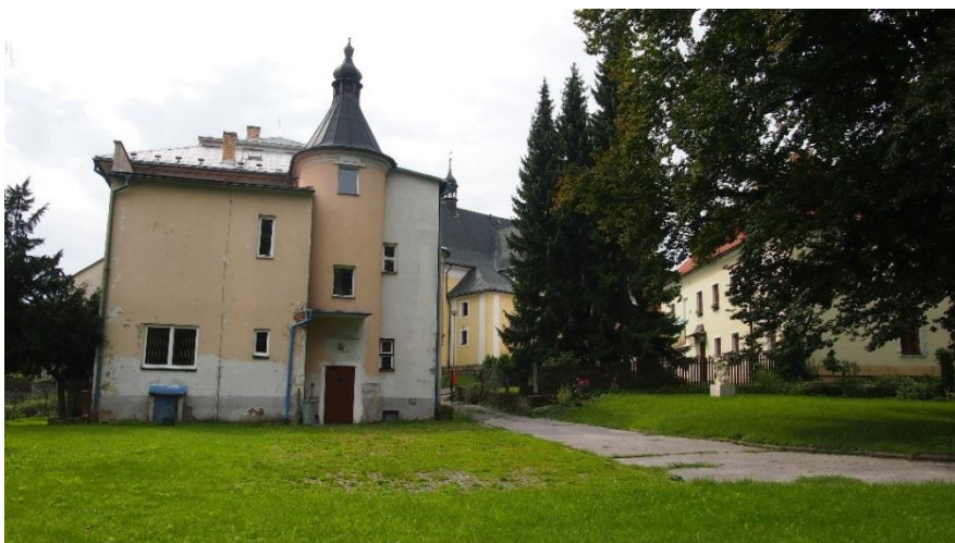
Obrázek 46: Zadní průčelí vily (dříve zimní zahrada) – plocha bývalého parteru a asfaltová komunikace
