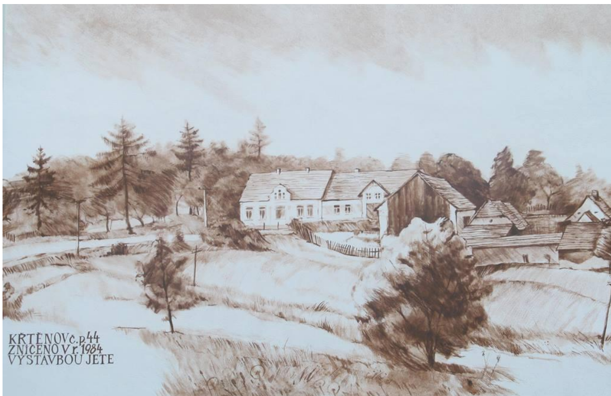
Obr. 21: Dům v obci Křtěnov
