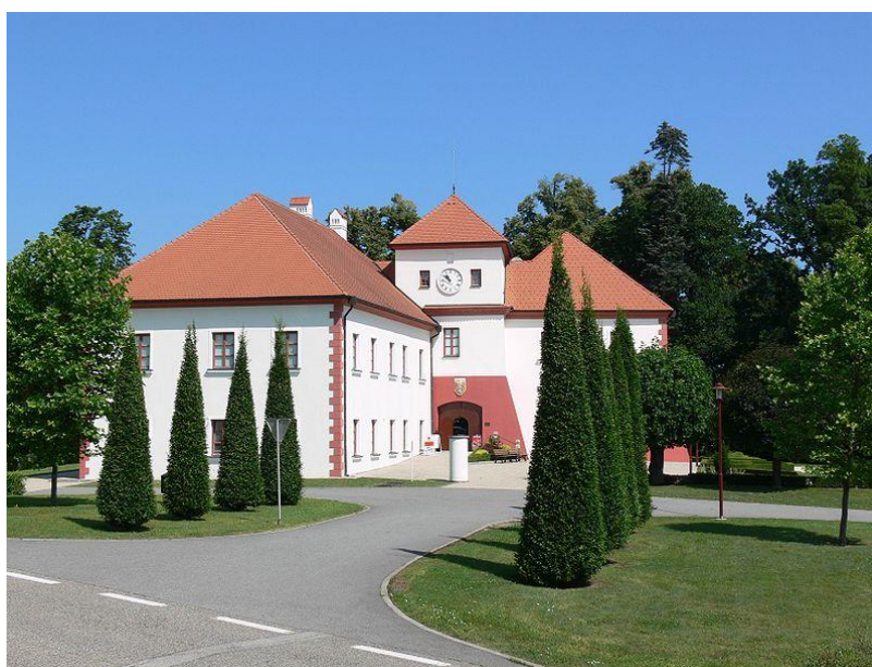
Obr. 16: Zámek Vysoký Hrádek po rekonstrukci
