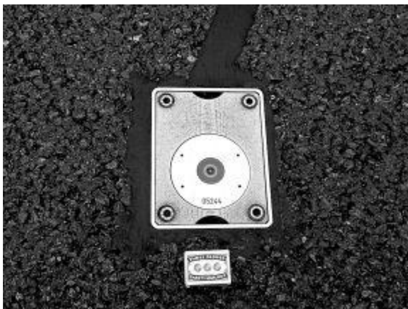
Obr. 17: Vozovkový snímač námrazy
