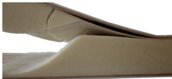
Obr. 6.9 Delaminace potahu a výplně, prasknutí výplně a vrstev překližky
