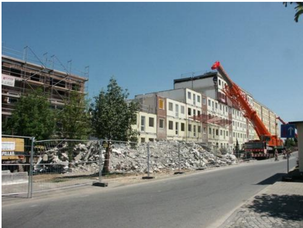
Obrázek č. 2: Strhávání bytových domů v Drážďanech (Zdroj: Wiechmann T., 2013)
