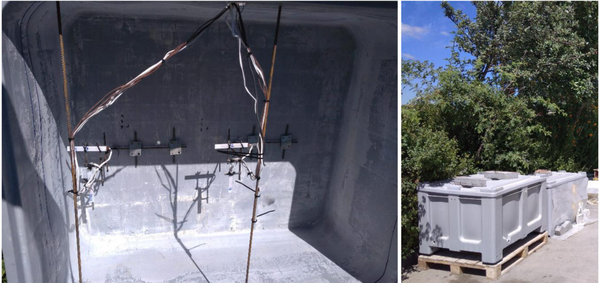
Obr. 18: Výroba betonových bloků z čerstvého betonu [fotoarchiv řešitelského kolektivu projektu GAČR č. 19-22708S].
