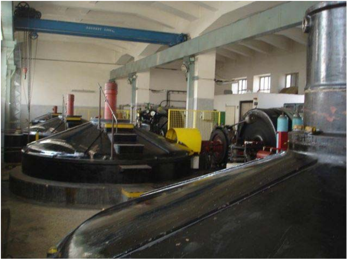
Příloha 3 Prostor strojovny před rekonstrukcí (Dovel.cz 2013)
