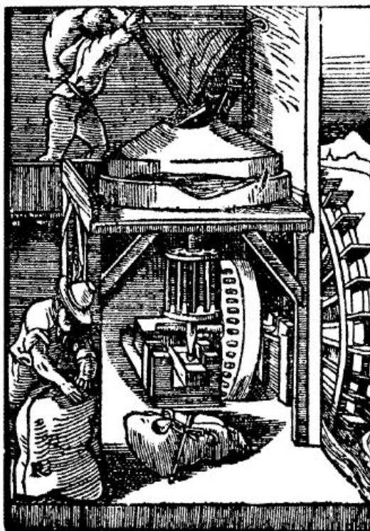
Obrázek 4 Vodní mlýn římského stavitele Vitruvia Pollia (Bednář 1989)
