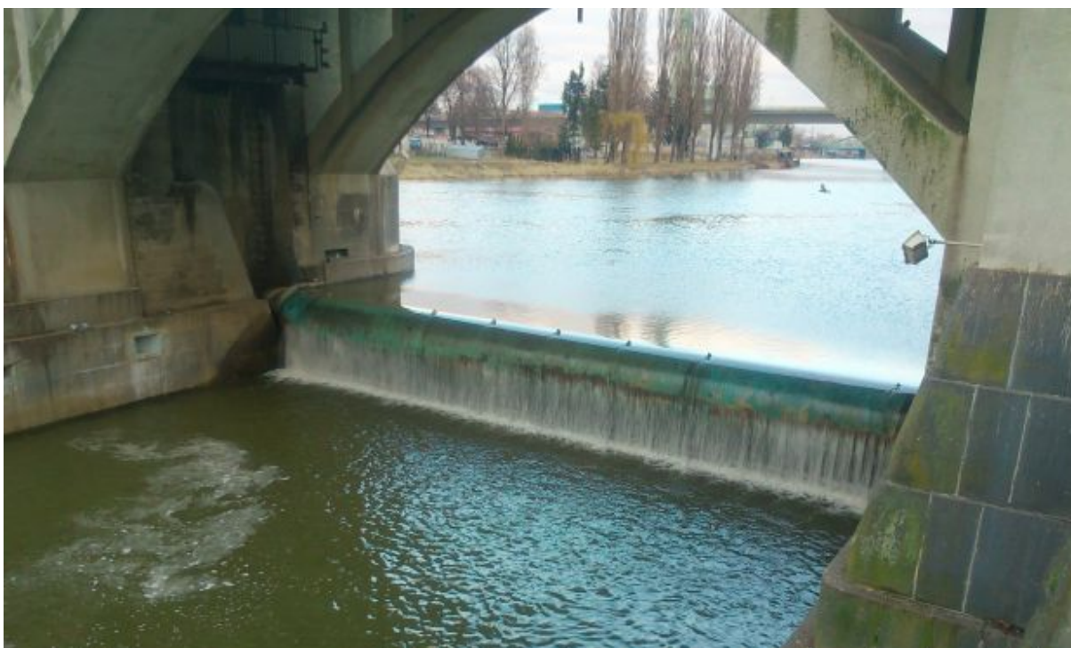
Obrázek 14 První pole jezu umístěné v konstrukci Masarykova mostu
