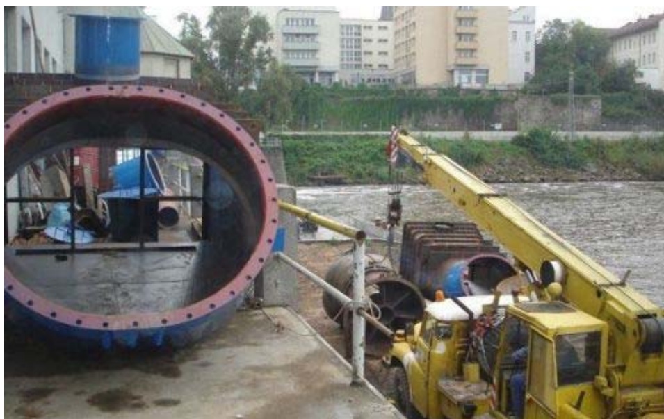
Obrázek 19 Průběh rekonstrukce (Dovel.cz 2013)
