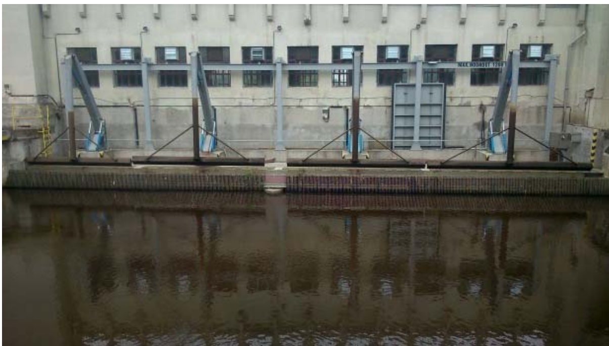
Obrázek 16 Budova elektrárny - pohled ze strany vtoku
