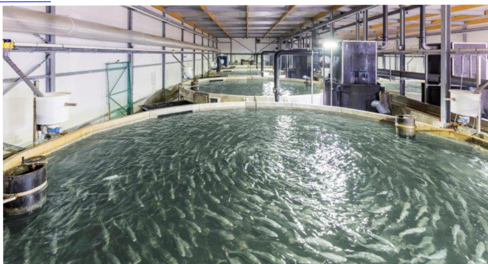
Obr. 7 Fotografie ukazuje chov ryb v RAS, dostupné z:
